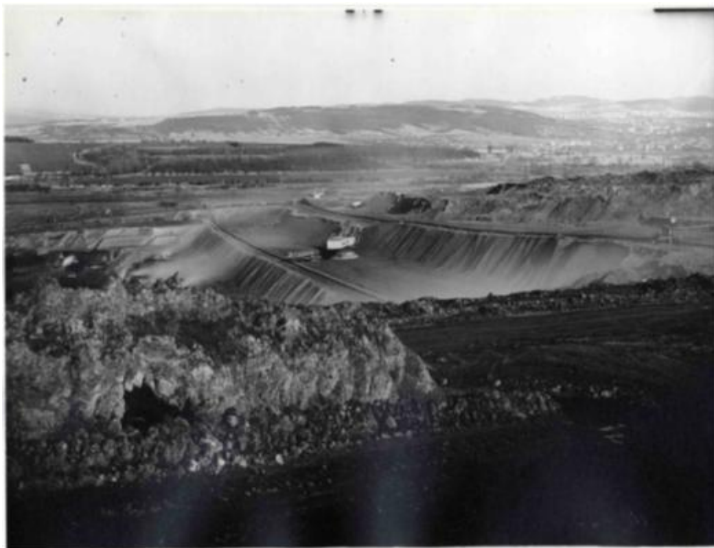
Obr. č. 5 Odklíz nadložních zemin korečkovým rypadlem RK400 1990 (PKÚ)
