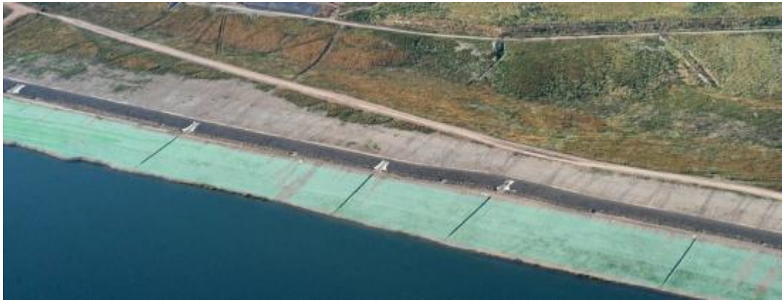
Obr. č. 6 Protiabrazivní opatření – kamenný zásyp po obvodu jezera Milada 2004 (PKÚ) ( http://www.pku.cz/pku/nahled.php?type=soucasnost_chabarovice&filename=jch_protiabrazie )
