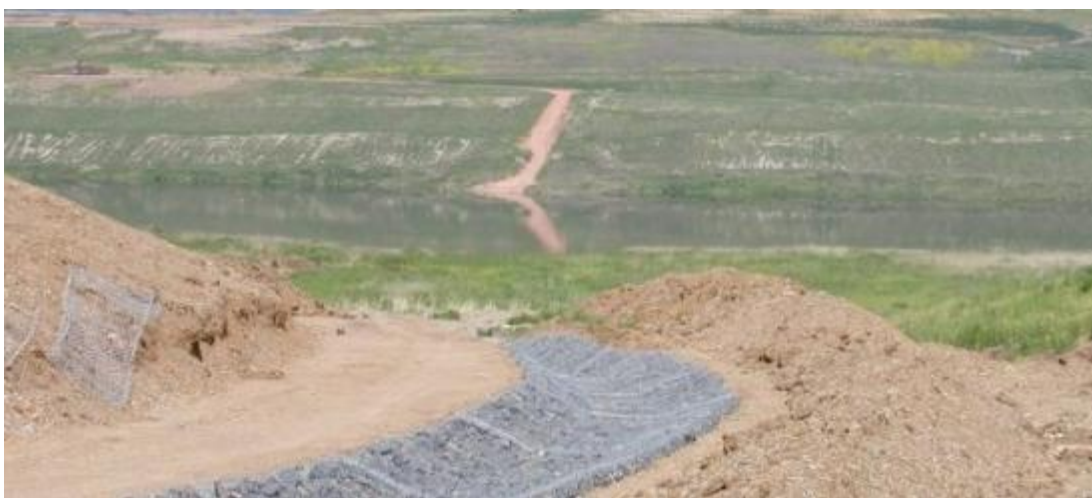
Obr. č. 8 Oprava odvodňovacího příkopu (PKÚ) ( http://www.pku.cz/pku/gallery.php?type=rekultivace&num=18 )
