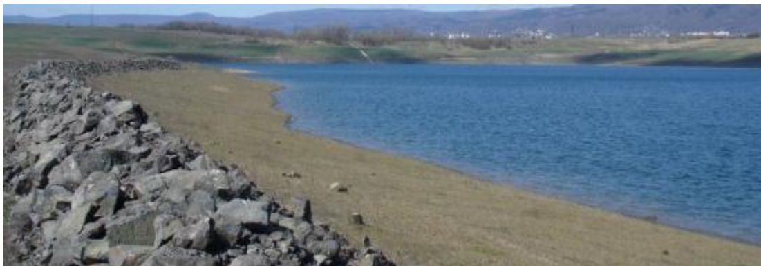
Obr. č. 6 Protiabrazivní opatření – kamenný zásyp po obvodu jezera Milada 2004 (PKÚ) ( http://www.pku.cz/pku/nahled.php?type=soucasnost_chabarovice&filename=jch_protiabrazie )
