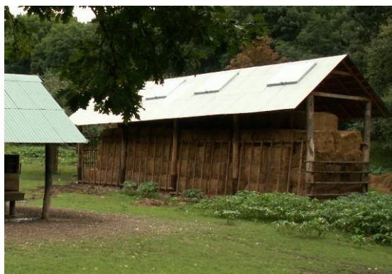
Obr. 9: Seník se střešními otvory (zdroj: autor 2010)
