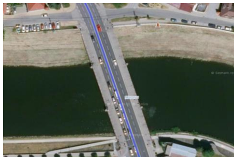
Obr. 2.4. Most na ulici Zerzavice
