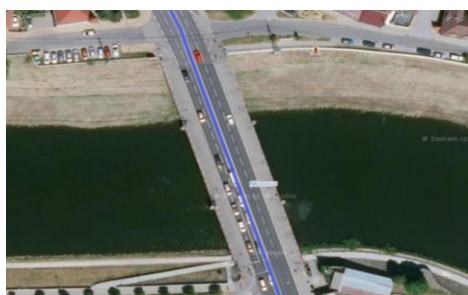
Obr. 2.20. Most na ulici Zerzavice
