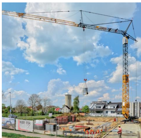
Obr. 6.17. Věžový jeřáb Liebherr 65K.1 Zdroj: https://www.liebherr.com
