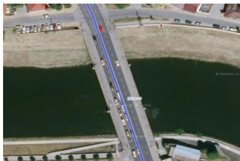
Obr. 2.15. Most na ulici Zerzavice
