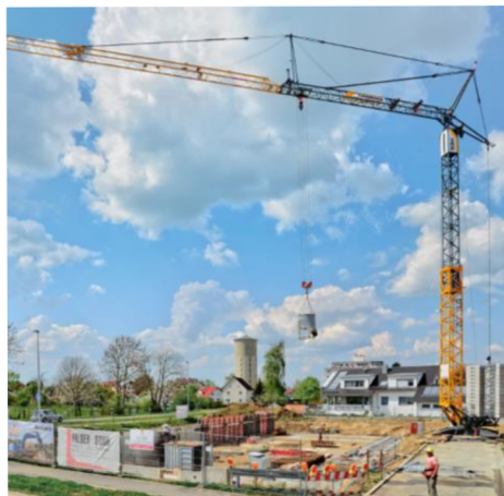
Obr. 6.17. Věžový jeřáb Liebherr 65K.1 Zdroj: https://www.liebherr.com
