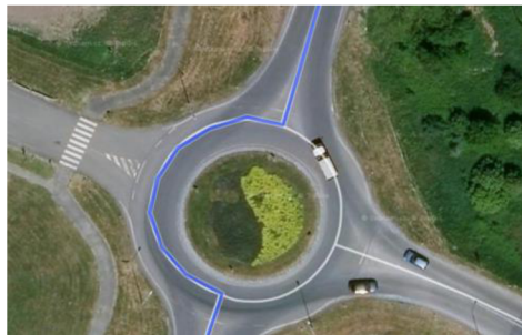
Obr. 2.24. Kruhová křižovatka na ulici Huštěnovská
