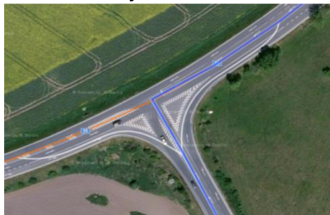
Obr. 2.21. Obrat na silnici III. třídy 42824
