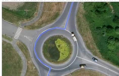
Obr. 2.8. Kruhová křižovatka na ulici Huštěnovská
