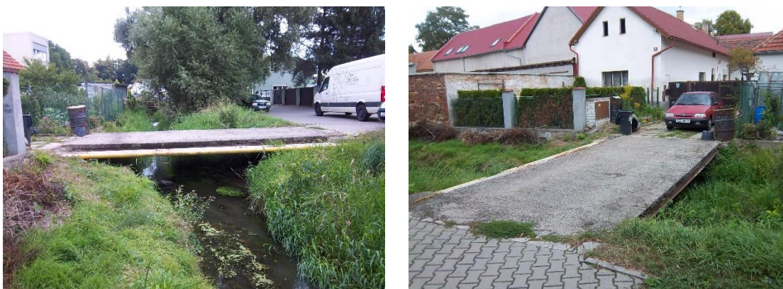
Fotografie 23, 24 – betonový most 9,270 ř. km. (Autorka).
