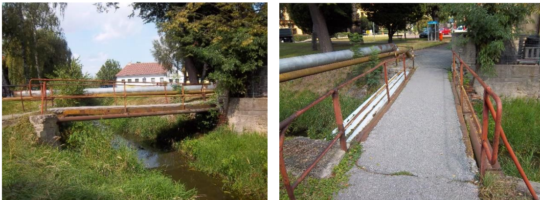
Fotografie 21, 22 – lávka pro pěší 9,219 ř. km. (Autorka).
