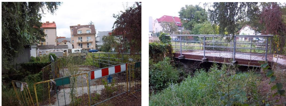
Fotografie 25, 26 – betonový most 9,301 ř. km. (Autorka).
