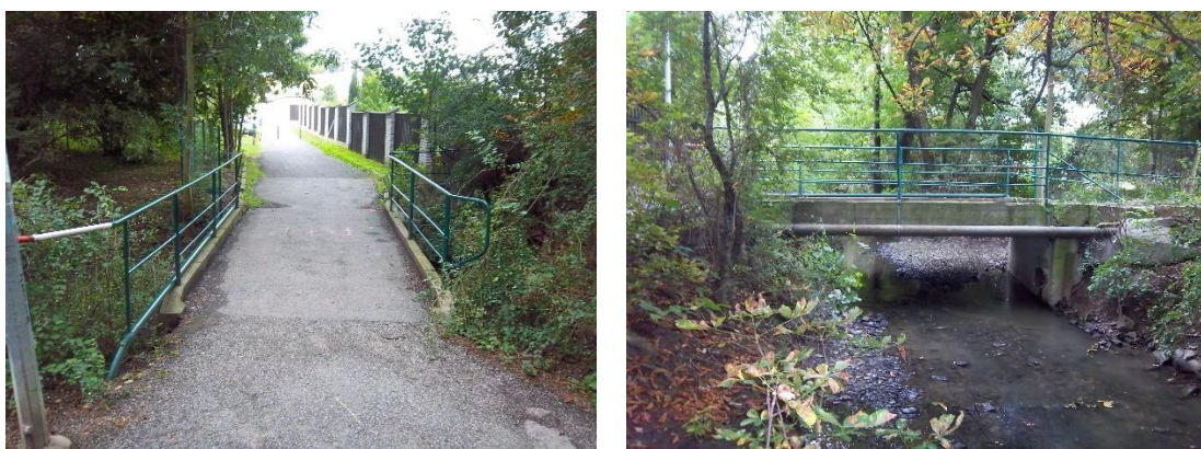
Fotografie 29, 30 – betonový most 9,566 ř. km. (Autorka).
