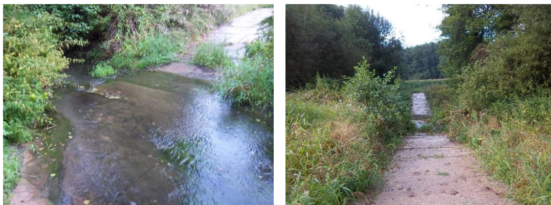
Fotografie 1, 2 – panelový brod na 8,053 ř. km (Autorka).
