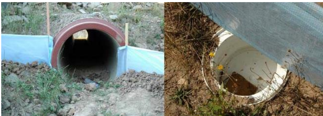
Obr. 19: Bariéry pro obojživelníky. Vlevo migrační objekt, vpravo padací past (Anděl et al., 2011)
