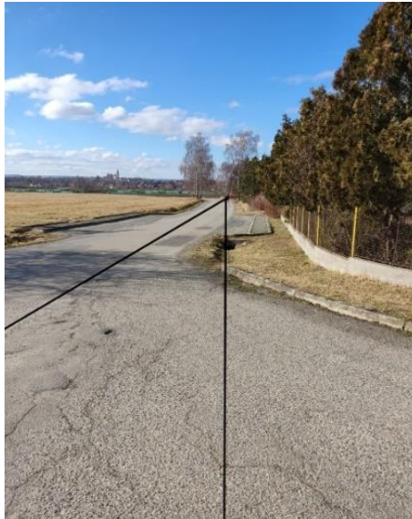
Obrázek č. 49 - Pravý rozhledový trojúhelník při výjezdu z místní komunikace na hlavní pozemní komunikaci
