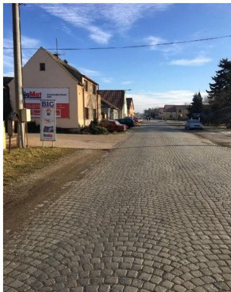
Obrázek č. 24 - Sjezd k místní firmě v prostoru zastávky BUS
