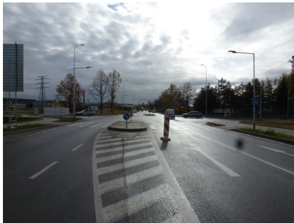
Obrázek 40 - Odpovídající nasvětlení přechodu pro chodce
