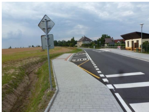
Obrázek č. 39 - Odpovídající VDZ v zastávce BUS
