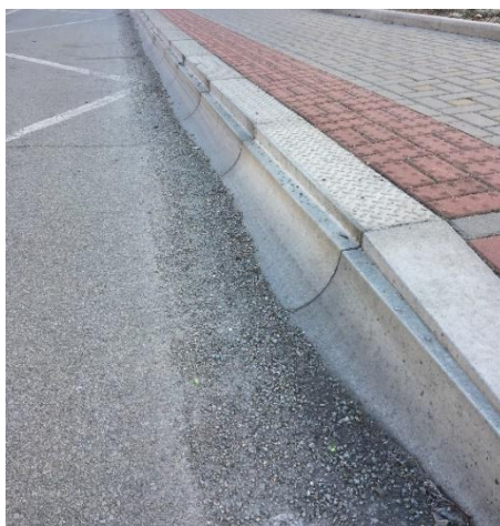
Obrázek č. 30 - Realizovaný varovný pás
