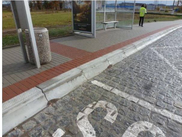
Obrázek č. 38 - Odpovídající stavební úpravy na zastávce BUS
