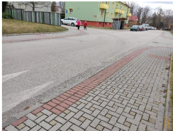
Obrázek č. 28 - Druhé místo pro přecházení na místní komunikaci
