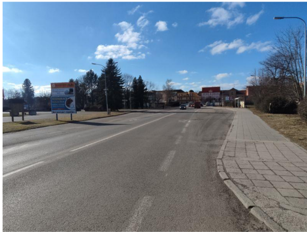
Obrázek č. 19 - Dopravně neuspořádané plochy zálivů zastávek BUS
