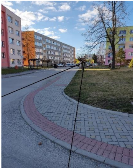
Obrázek č. 47 - Pravý rozhledový trojúhelník při výjezdu z místní komunikace na hlavní pozemní komunikaci
