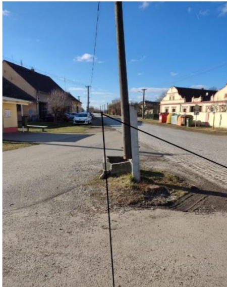
Obrázek č. 48 - Levý rozhledový trojúhelník při výjezdu z místní komunikace na hlavní pozemní komunikaci
