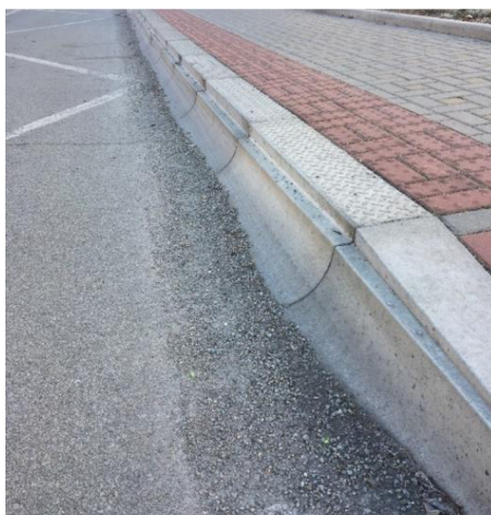
Obrázek č. 30 - Realizovaný varovný pás
