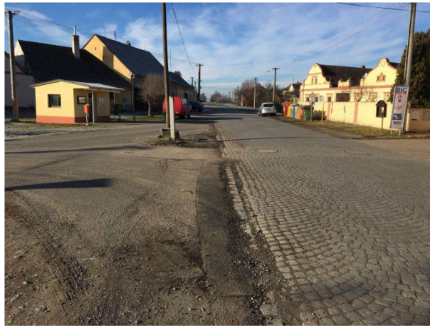
Obrázek č. 23 - Umístění zastávka BUS v křižovatce pozemních komunikací
