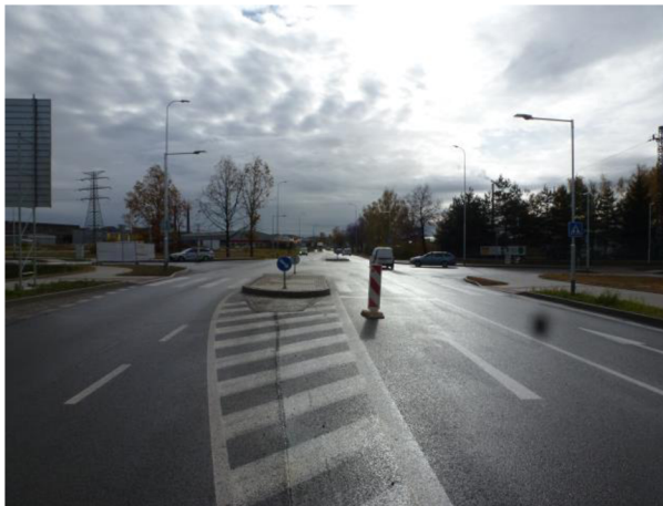
Obrázek 40 - Odpovídající nasvětlení přechodu pro chodce
