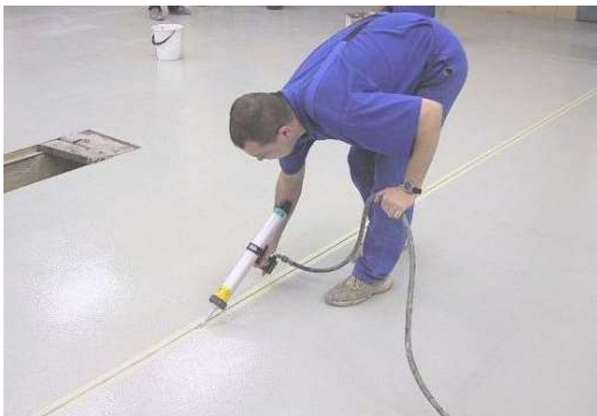
Obrázek 9-4 Tmelení dilatačních spár [48]
