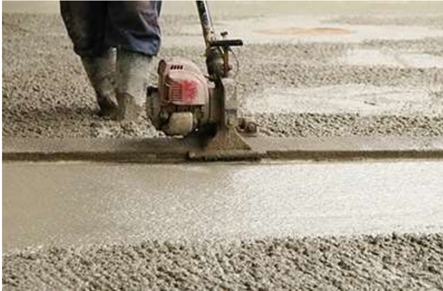
Obrázek 9-2 Stahování vibrační latí [46]
