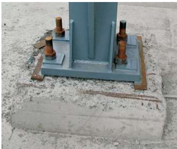
Obrázek 7-2 Osazení sloupu na kotevní koš, před zálivkovou maltou. [44]
