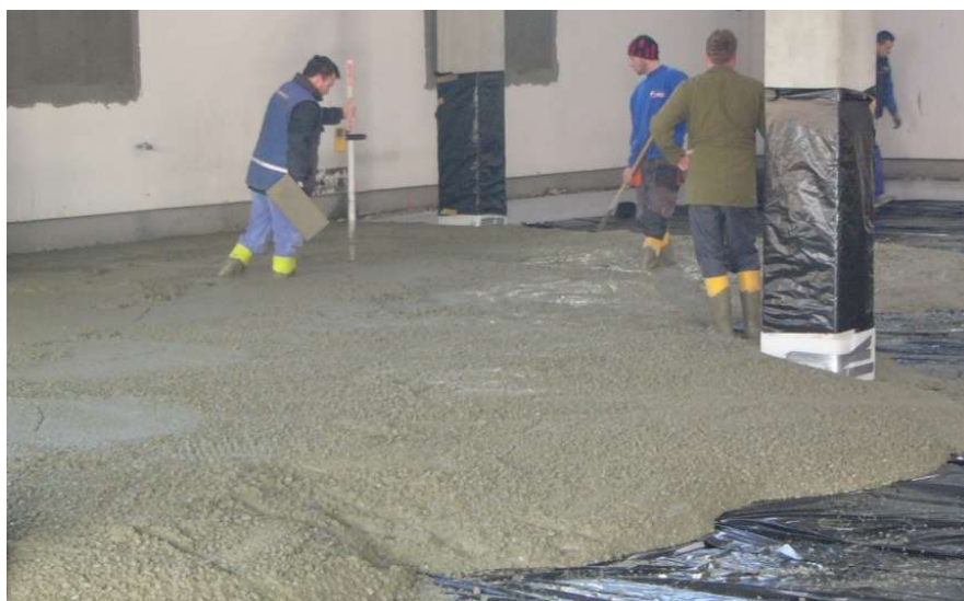
Obrázek 9-1 Provádění výškových terčů [45]
