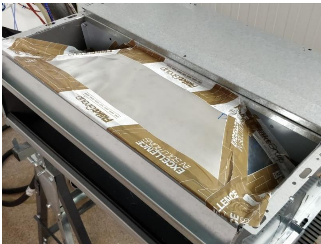
Obrázek 40: Vodící kanál umístěný ve výměňkové komoře
