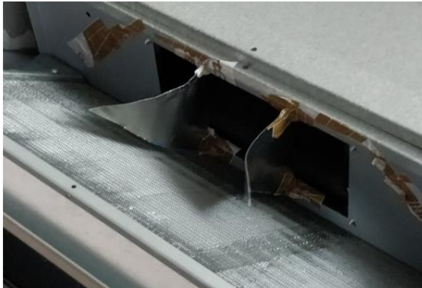
Obrázek 38: Vertikální rozváděcí plech upevněný na výdech ventilátoru
