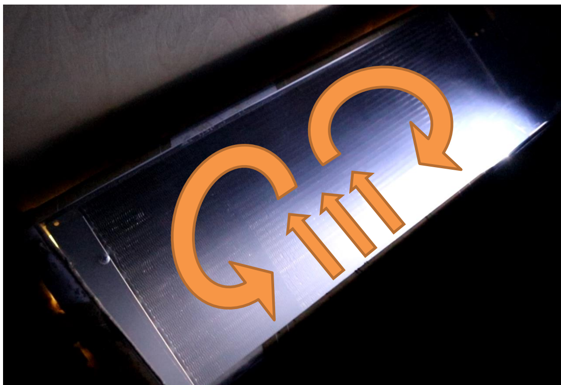
Obrázek 35: Profil proudění ve výměňkové komoře
