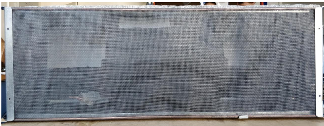
Obrázek 12: Filtr G1 umístěný na sání jednotky velikosti 2
