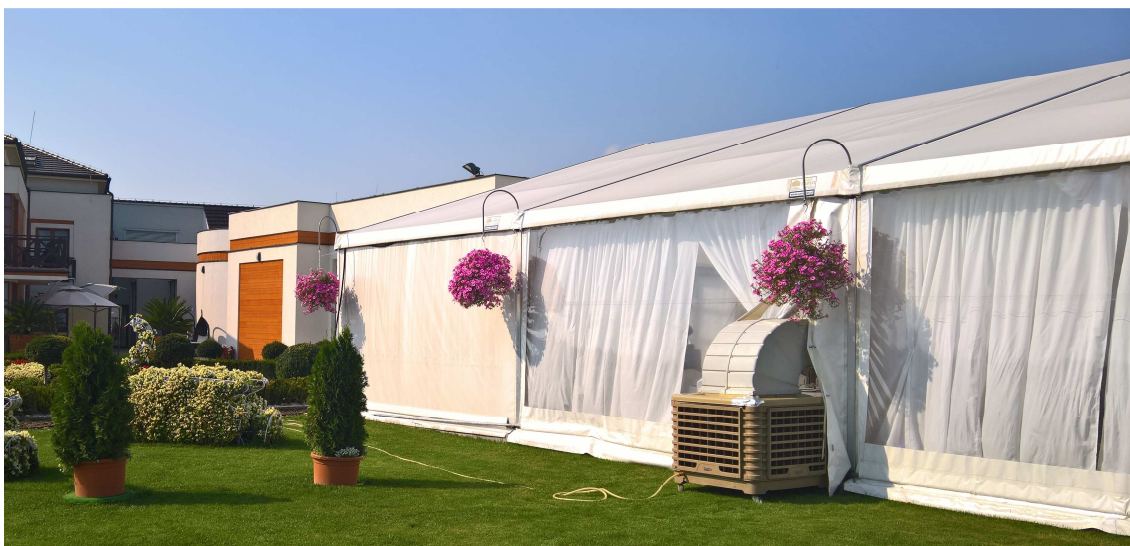
Obrázek B.22 Použití adiabatického chladiče pro chlazení svatebního stanu [18]
