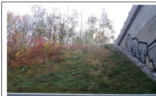
Obr. č. 20 – oplocení dálnice D1 (vlastní foto 2017)
