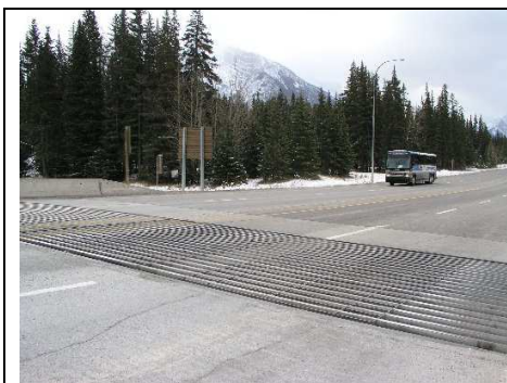
A: Rolovací zábrany proti vstupu zvěře na dopravní uzel
