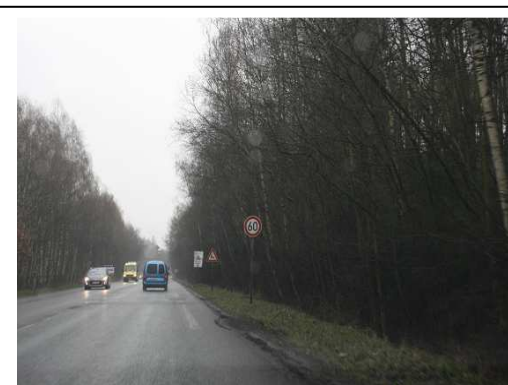
Obr. č. 22 – Pozemní komunikace Říčany u Prahy směr Mukařov (vlastní foto 2012)
