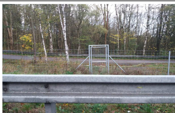
Obr. č. 19 – oplocení dálnice D1 (vlastní foto 2017)
