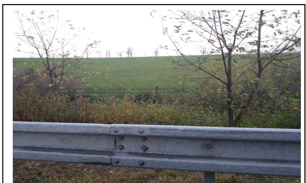
Obr. č. 21 – oplocení dálnice D1 (vlastní foto 2017) – bez oplocení
