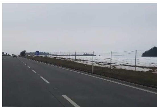
Obr. č. 16 – oplocení dálnice D1 (vlastní foto 2016)
