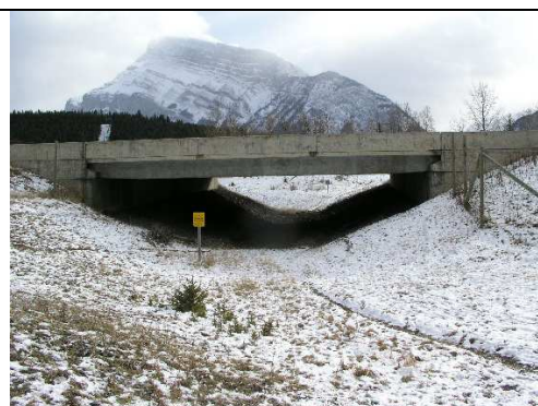
D: Kapacitní podchod pod dálnicí
