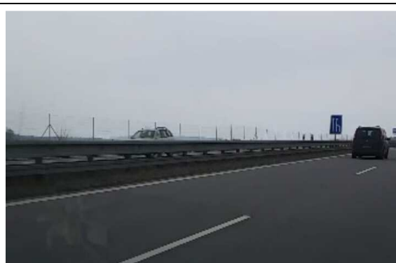
Obr. č. 17 – oplocení dálnice D1 (vlastní foto 2016)
