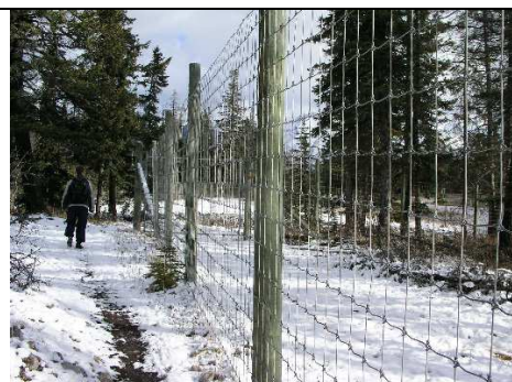
B: Vázané oplocení dálniční bariéry
