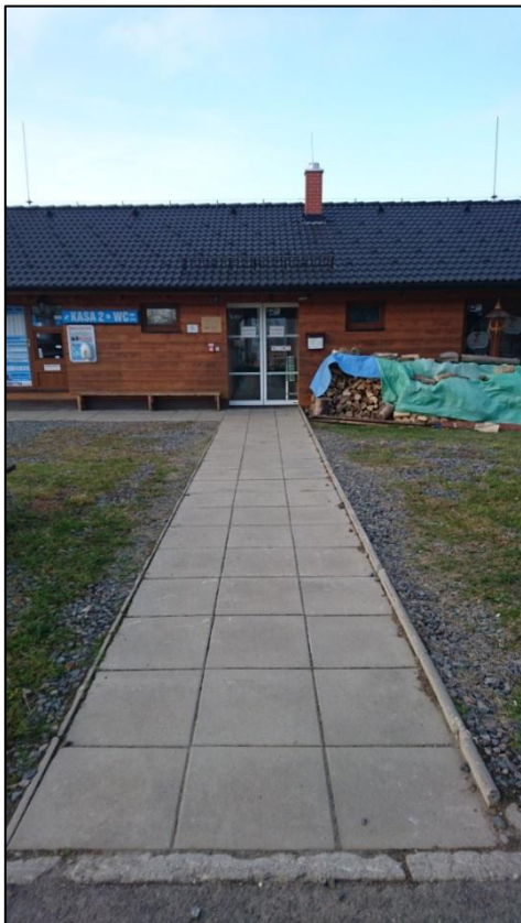
Obrázek 10. Přístup k hlavnímu vchodu
