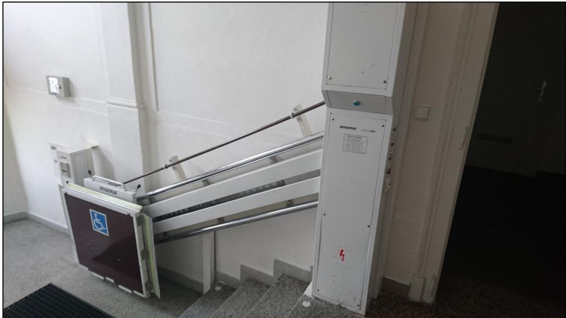
Obrázek 30. Plošina pro vstup do zvýšeného přízemí
