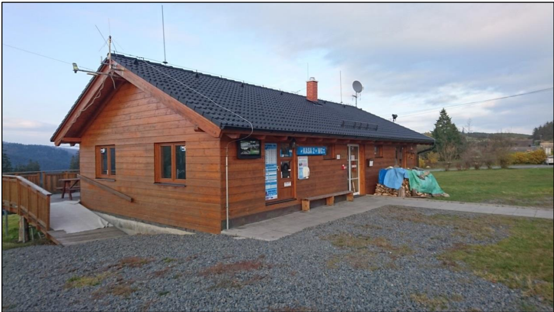
Obrázek 9. Ski areál Troják – celkový pohled na hlavní budovu se zázemím
