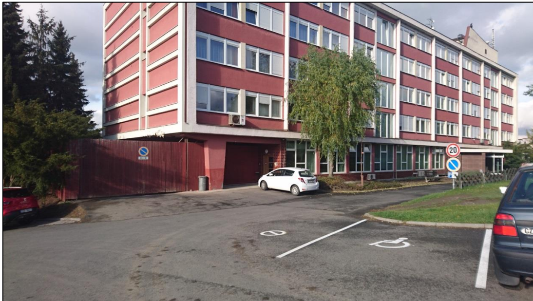
Obrázek 18. Celkový pohled na budovu Golf Clubu Kostelec z parkovací plochy
