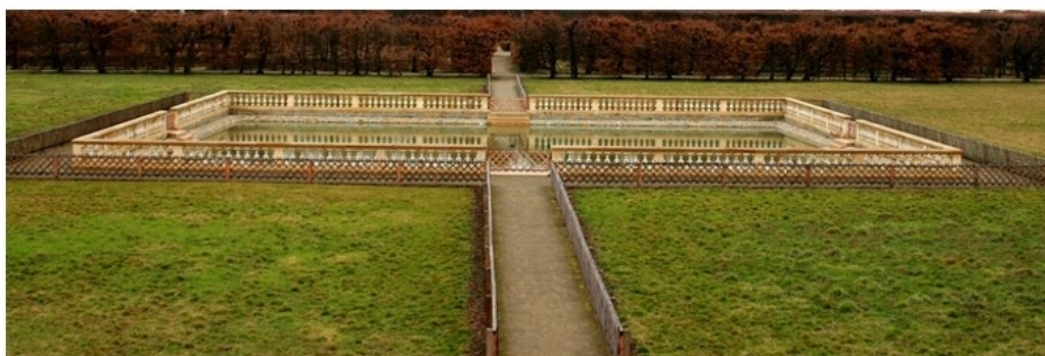
6. Celkový pohled na nádrž
