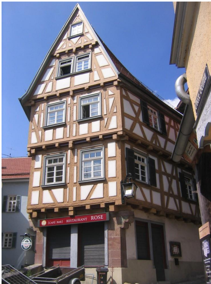
Obr. 11 Typický dům hrázděné konstrukce
