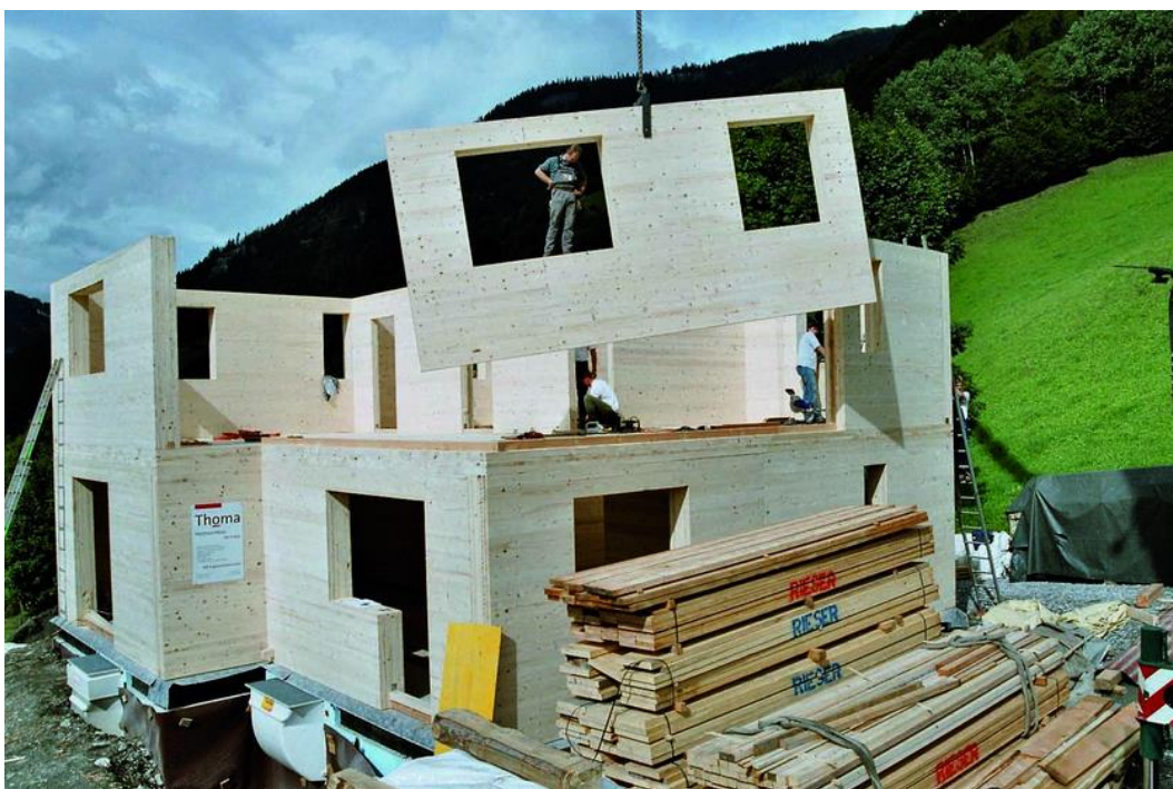
Obr. 3 Montáž druhého patra domu (webové stránky firmy Thoma-Holz)
