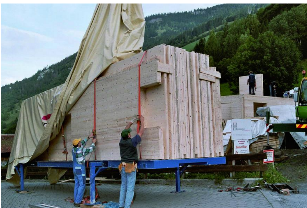
Obr. 1 Dovoz prefabrikovaných panelů na místo stavby (webové stránky firmy Thoma-Holz)
