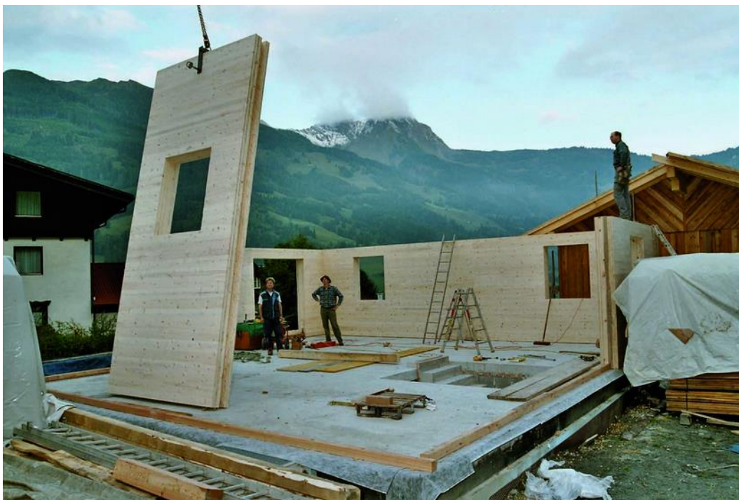
Obr. 2 Montáž jednotlivých panelů na základovou desku (webové stránky firmy Thoma-Holz)
