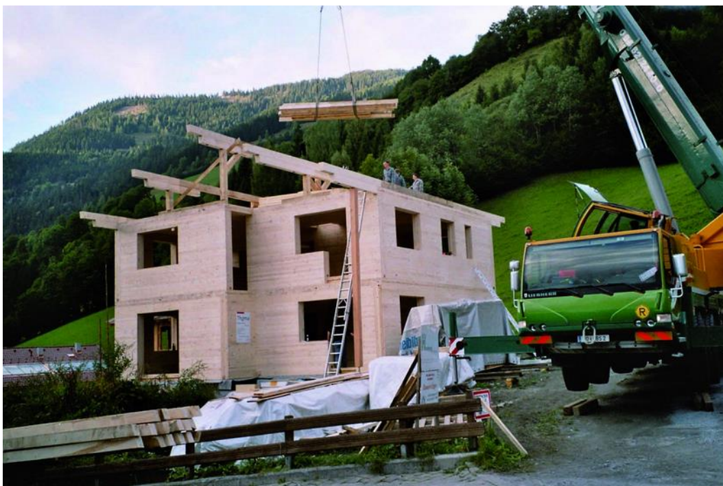
Obr. 4 Usazení krovů a celé střechy domu (webové stránky firmy Thoma-Holz)
