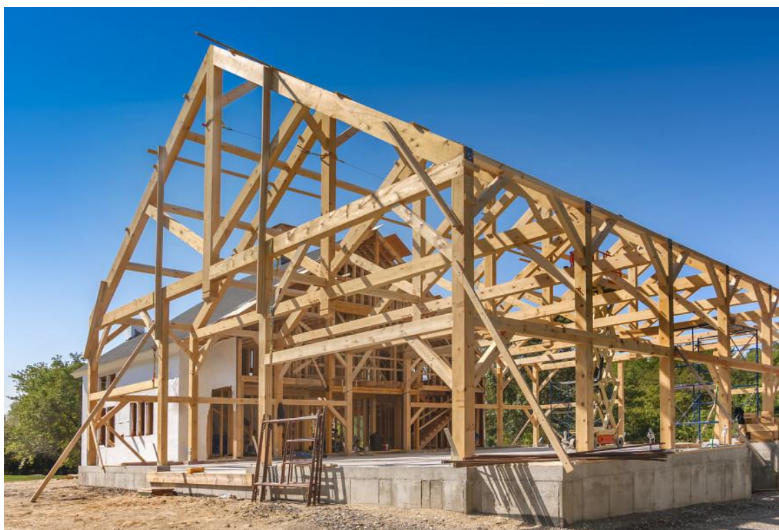
Obr. 8 Stavba skeletové soustavy- nosnou funkci tvoří skelet ze sloupů (webové stránky Dřevo & Stavby )
