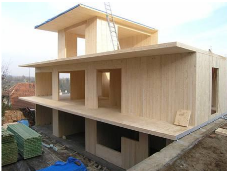
Obr. 9 Stavba rodinného domu z CLT panelů (webové stránky Bydlení.cz )
