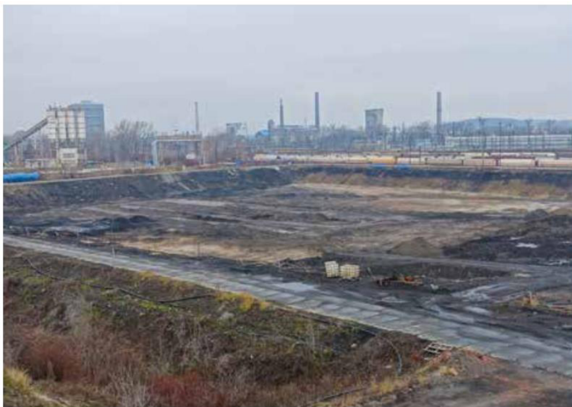
Obrázek č. 17: areál laguny Ostrava v Ostravě – rok 2022, zpracovány ropné kaly, příprava na sanaci kontaminované zeminy (zdroj: Odpadové fórum–DIAMO-rozhovor)
