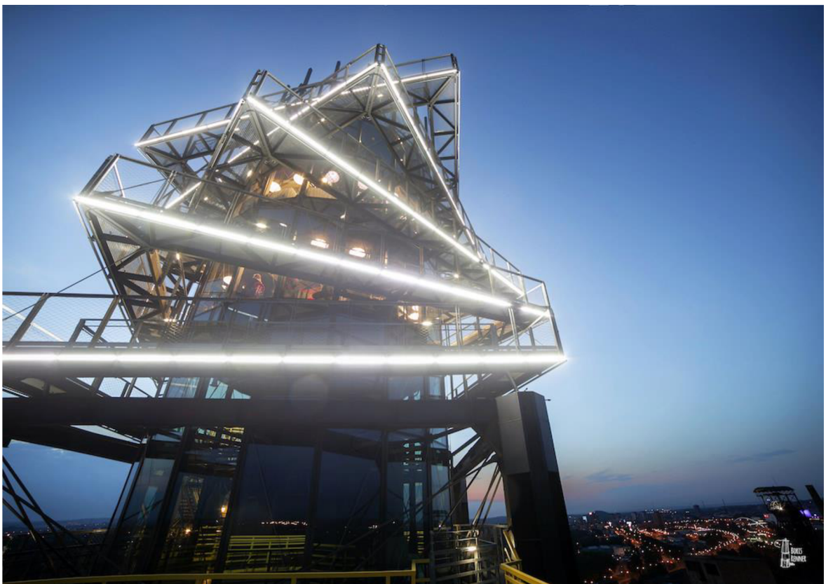
Obrázek č. 4: Pohled na nástavbu Vysoké pece č. 1 (zdroj: www.dolnivitkovice.cz )
