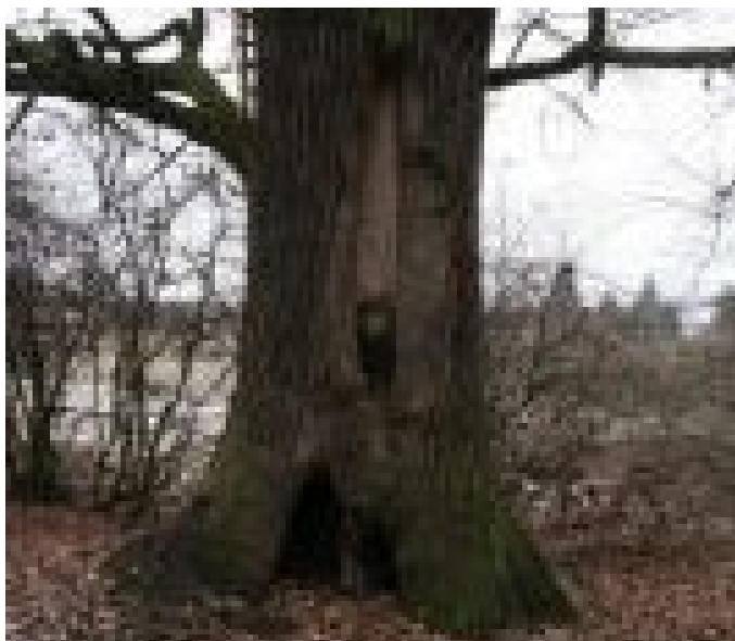
05_Dub nad Zhůří_Kmen - Východní strana - Celkový pohled
