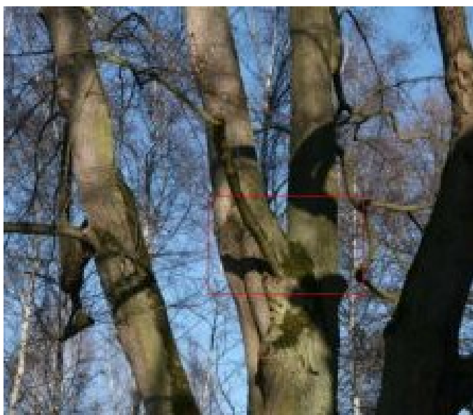
12_2321_Lípa u kaple v Úterý_Centrální samostatná osa - Místo sekundárního rozvětvení - Jižní stran
