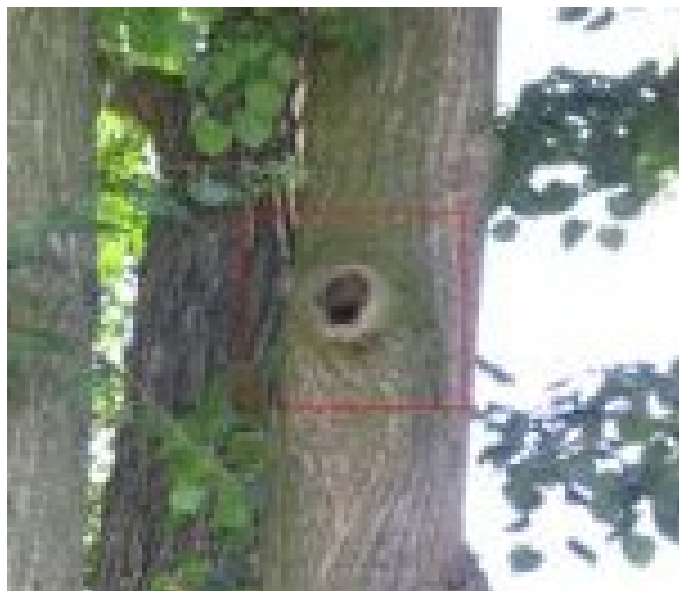
19_2336_Keslova lípa ve Střížovicích_Řezná rána - Západní osa - Spodní část - Průměr nad 0,10 m -
