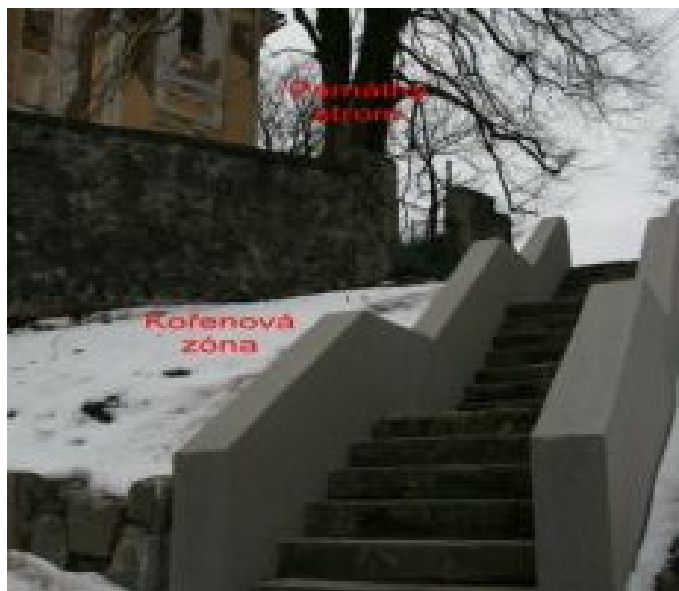
31_2345_Lípa v Čížkově_Stavební práce
