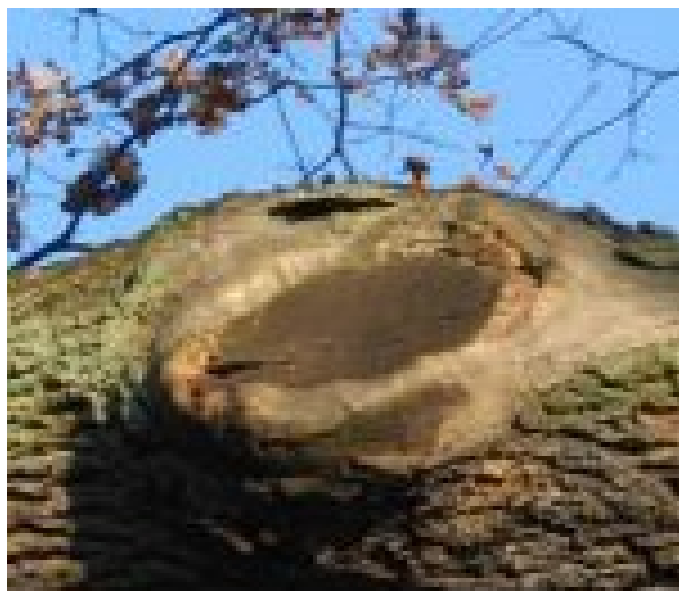
44_2363_Körnerův dub_Řezná rána - Koruna - Průměr nad 0,10 m
