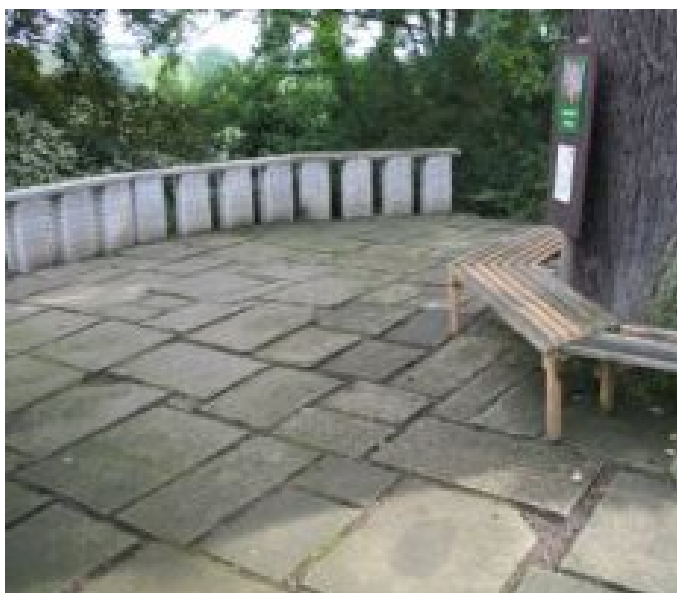
47_2363_Körnerův dub_Ostatní - Dlažba v okolí stromu
