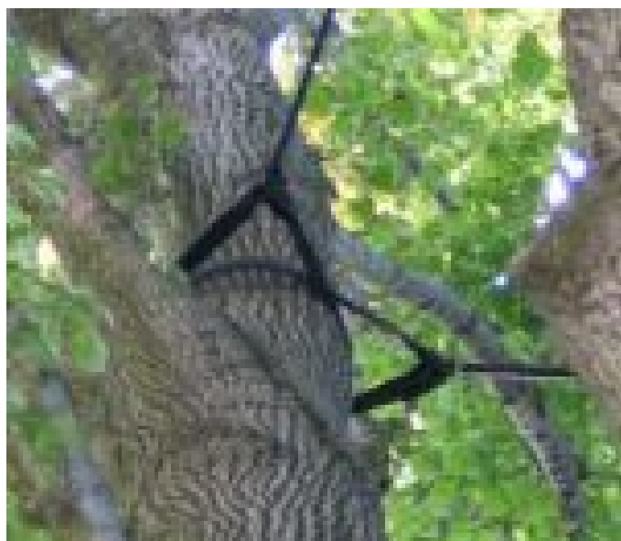
27_2345_Lípa v Čížkově_Koruna - Horní část - Bezpečnostní vazba - Kmenový pás - Detail
