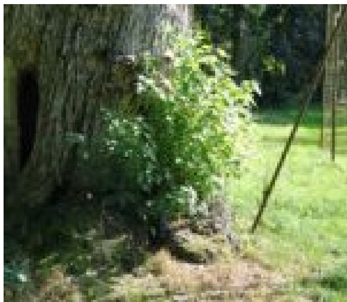
07_2346_Javor pod Zelenou Horou_Báze kmene - Severovýchodní strana - Výmladnost
