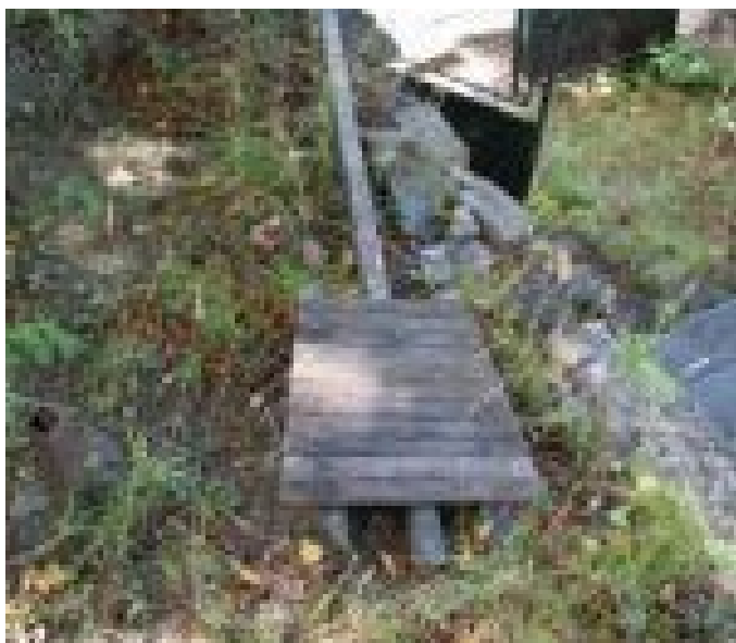
30_2345_Lípa v Čížkově_Nefunkční označení památného stromu
