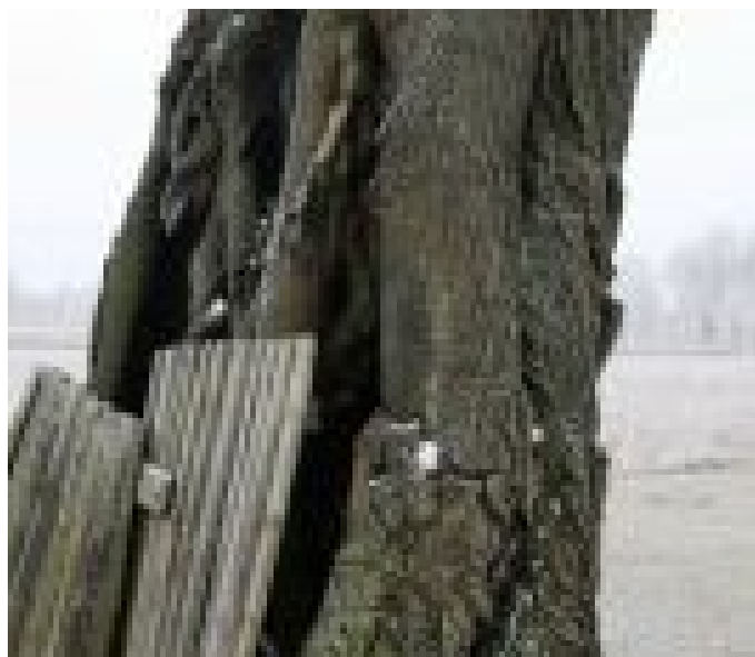
24_2352_Lípa u Gigantu_Kmen - Severní strana - Velká otevřená dutina - Provizorní zábrana - Celko
