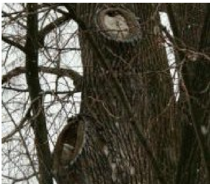
31_2356_Milečská lípa_Řezné rány - Koruna - Průměr nad 0,10 m
