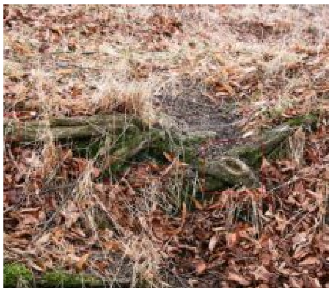
10_2360_Vrčeňská lípa_Kořenové náběhy - Severozápadní strana - Živelná stezka - Poškození -
