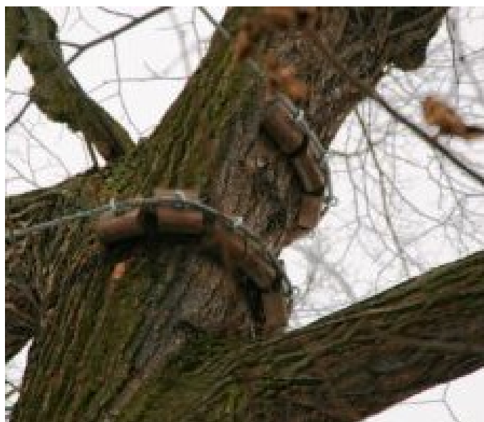
14_5198_Lípa ve Štěnovicích_Koruna - Střední část - Předepjatá bezpečnostní vazba z podkladnic
