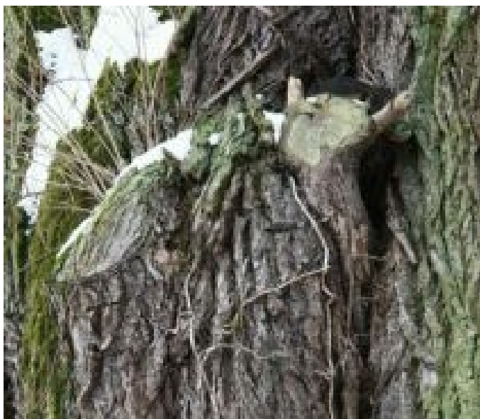
29_2340_Letinská lípa_Řezná rána - Kmen - Průměr do 0,10 m - Detail
