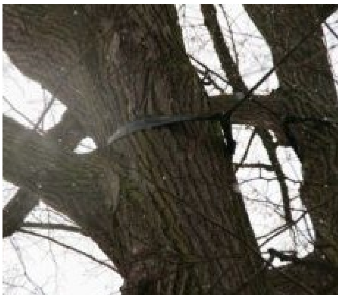
23_2358_Podhůřská lípa_Koruna - Horní část - (Předepjatá) bezpečnostní vazba - Kmenový pás - Deta
