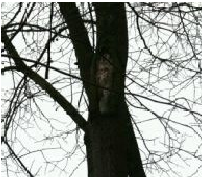
18_2353_Lípa u Moravců_Koruna - Defekt po vylomené větvi - Detail
