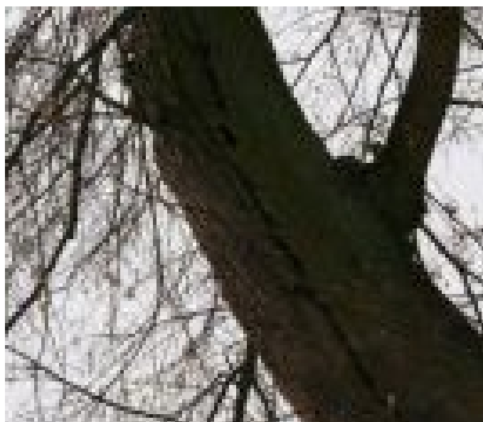
22_2323_Alej Vzdechů_Kmen - Podélná prasklina - Detail
