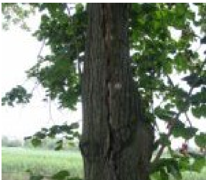
024_2364_Alej Kilometrovka_Kmen - Podélná prasklina
