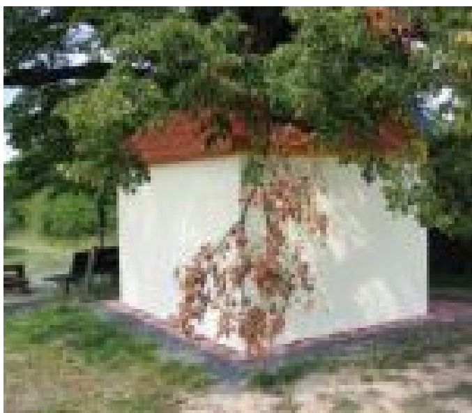
33_2351_Lípa pod Ticholovcem_Koruna - Východní strana - Spodní část - Zlomená větev
