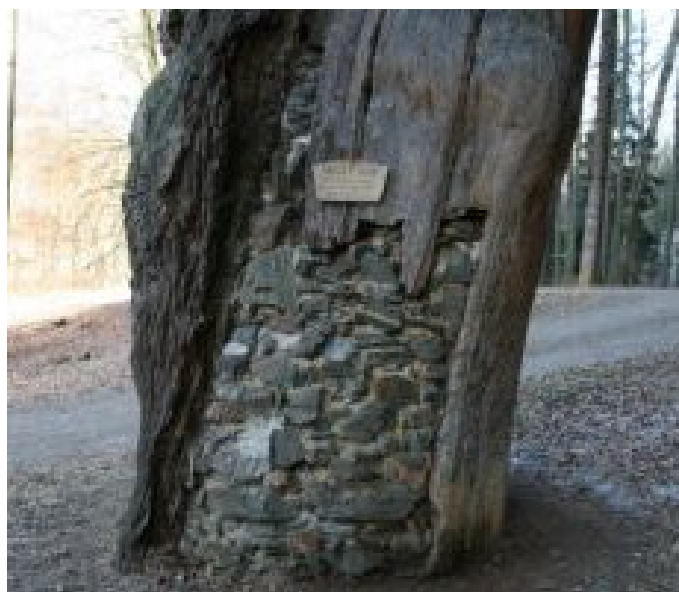
11_2326_Žižkův dub_Kmen - Jižní strana - Spodní část - Vyzděná dutina
