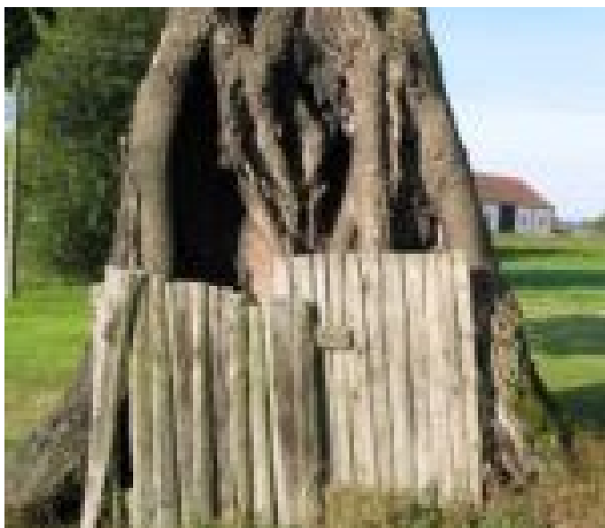
23_2352_Lípa u Gigantu_Kmen - Severní strana - Velká otevřená dutina - Provizorní zábrana - Celko
