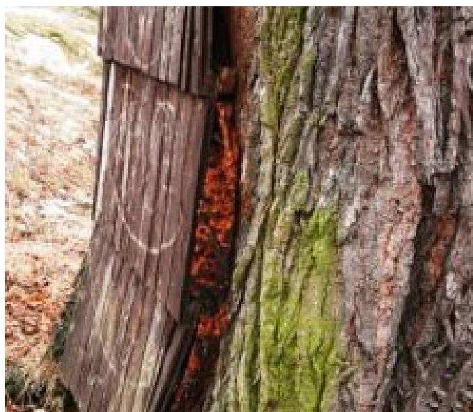
14_2360_Vrčeňská lípa_Kmen - Jihovýchodní strana - Zastřešená dutina - Prostor mezi kmenem a zast
