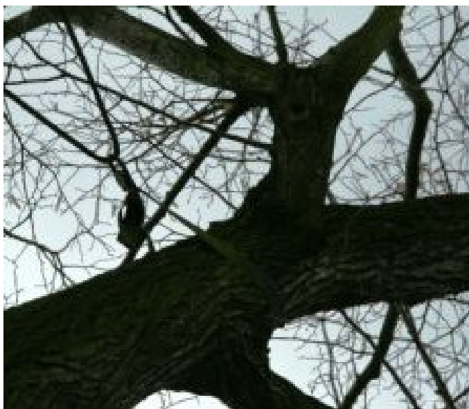
41_2360_Vrčeňská lípa_Koruna - Střední část - Předepjatá bezpečnostní vazba - Kmenový pás - Detai
