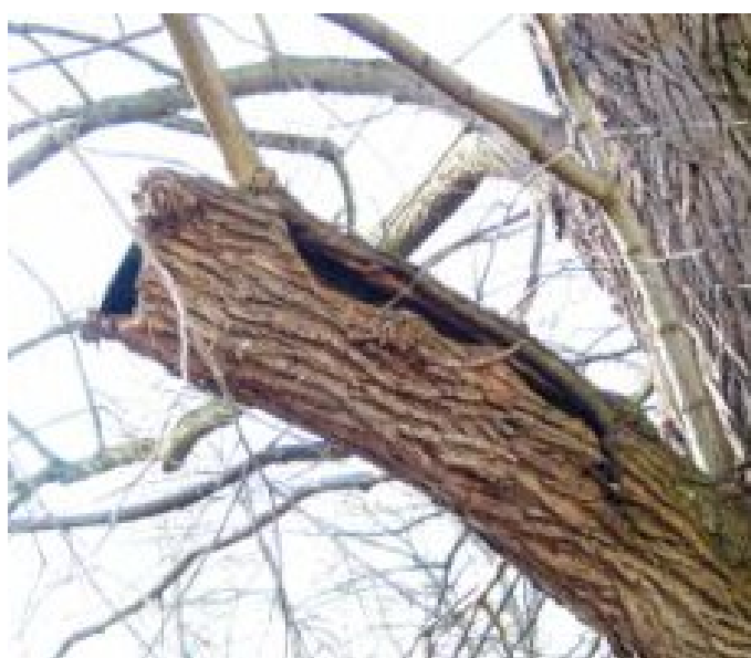
30_2368_Koterovská lípa_Koruna - Východní strana - Spodní část - Vyhnílá kosterní větev - Detail
