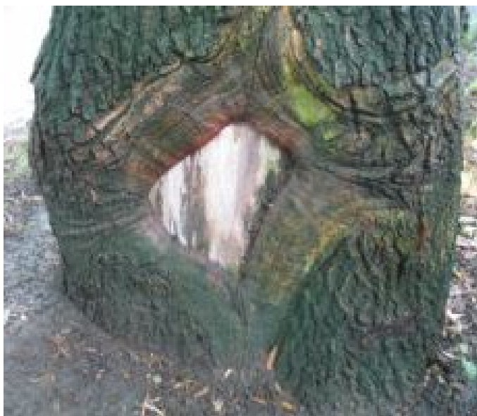
010_2364_Alej Kilometrovka_Báze kmene - Zavalující se defekt po odloupnuté borce
