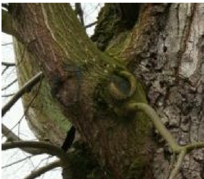
31_2354_Lípa u Palackých_Řezná rána - Koruna - Průměr do 0,10 m
