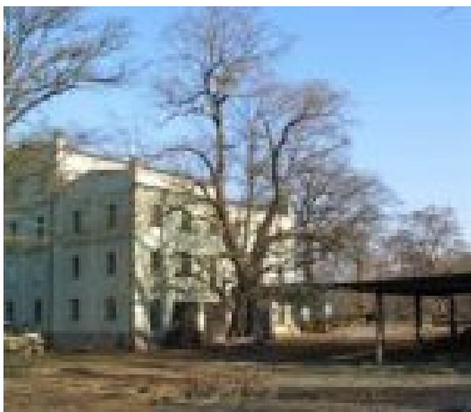
05_2368_Koterovská lípa_Celkový pohled - Bezlistý stav - Jihozápadní strana
