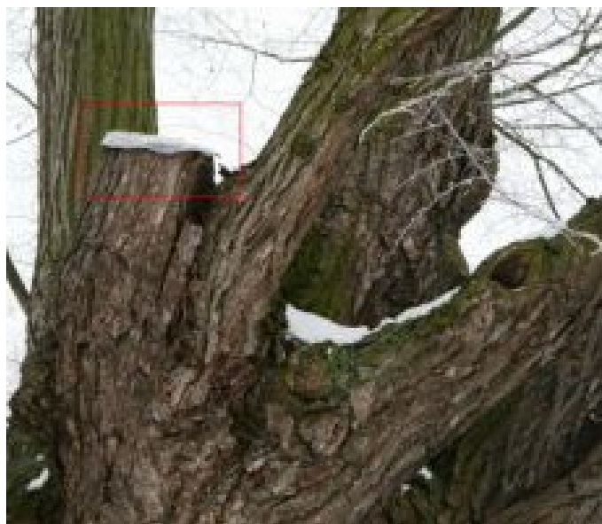
32_2351_Lípa pod Ticholovcem_Kmen - Místo primárního rozvětvení - Zastřešení samostatné osy reduk
