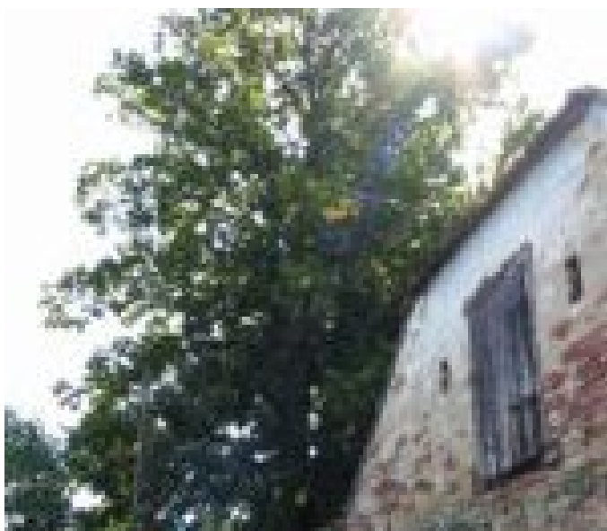
01_2354_Lípa u Palackých_Celkový pohled - Olistěný stav - Severní strana
