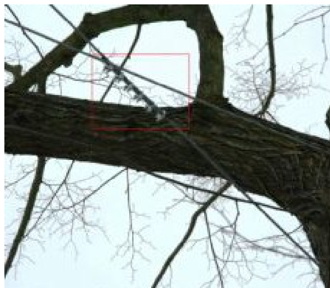
16_5198_Lípa ve Štěnovicích_Koruna - Střední část - Předepjatá bezpečnostní vazba z podkladnic -
