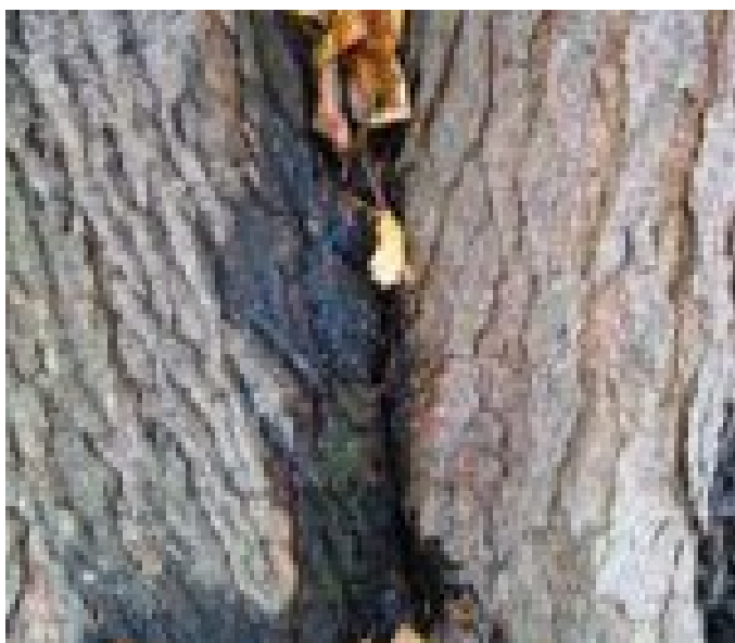
17_Jedlovec v Újezdci_Kmeny - Srůst severní a jižní samostatné osy - Detail
