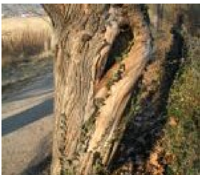
090_2364_Alej Kilometrovka_Strom - Havarijní stav - Javor mléč - Kmen
