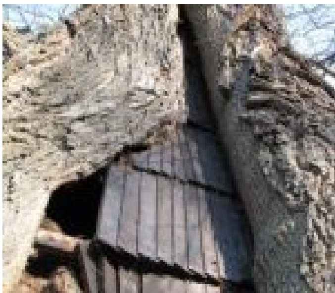
15_2368_Koterovská lípa_Kmen - Jihozápadní strana - Zastřešení dutiny šindelovou stříškou - Detail
