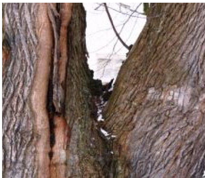
18_2324_1.2_Lípy v Číhané_Kmen - Místo primárního rozvětvení - Severní strana - Detail
