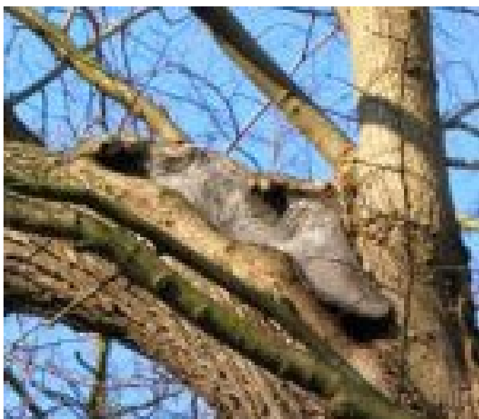
35_2368_Koterovská lípa_Koruna - Horní část - Defekt po vylomené kosterní větvi - Zastřešení defe
