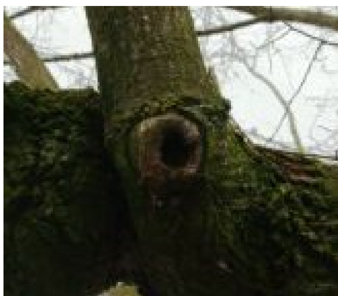
21_2353_Lípa u Moravců_Řezná rána - Koruna - Průměr do 0,10 m
