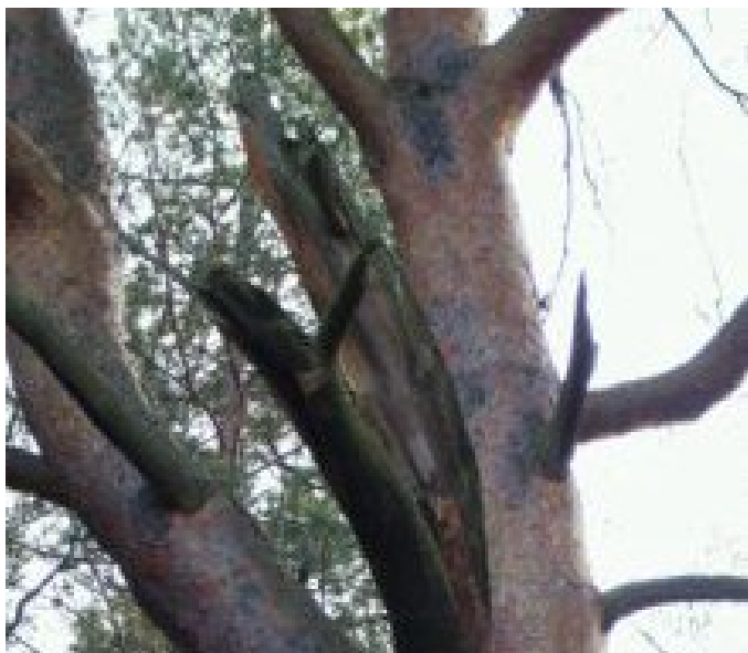
15_4721_Borovice u Košináře_Sekundární východní samostatná osa - Uschlá slabší větev - Zlom silně
