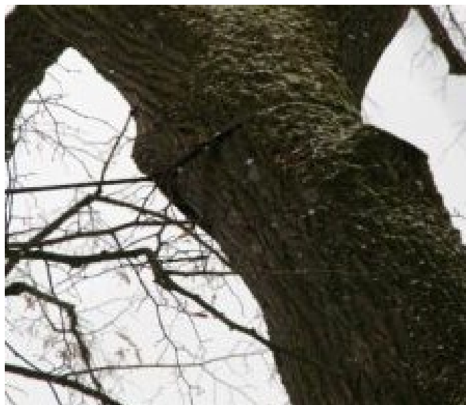
22_2358_Podhůřská lípa_Koruna - Horní část - (Předepjatá) bezpečnostní vazba - Kmenový pás - Deta
