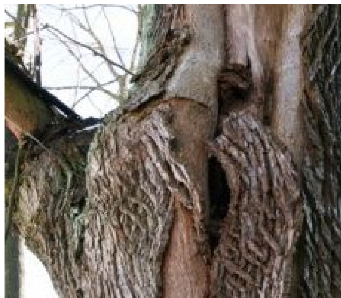
22_2324_1.2_Lípy v Číhané_Sekundární východní samostatná osa - Severní strana - Prasklina - Střed
