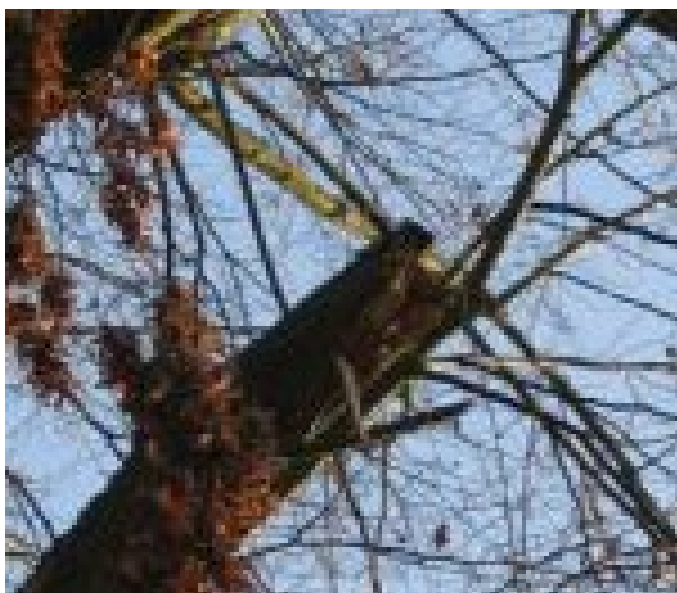
36_2334_Nučická lípa_Koruna - Zalomená silněji větev - Detail
