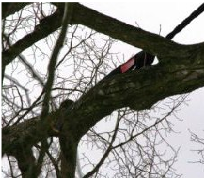
25_2347_Chloumecká lípa_Koruna - Horní část - Nepředepjatá bezpečnostní vazba - Instalace 2007 -
