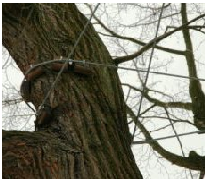
15_5198_Lípa ve Štěnovicích_Koruna - Střední část - Předepjatá bezpečnostní vazba z podkladnic -
