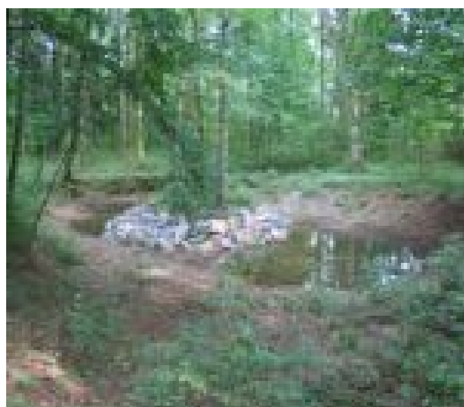
14_2343_Douglaska v Újezdci_Ostatní - Zrekonstruované napájecí jezírko
