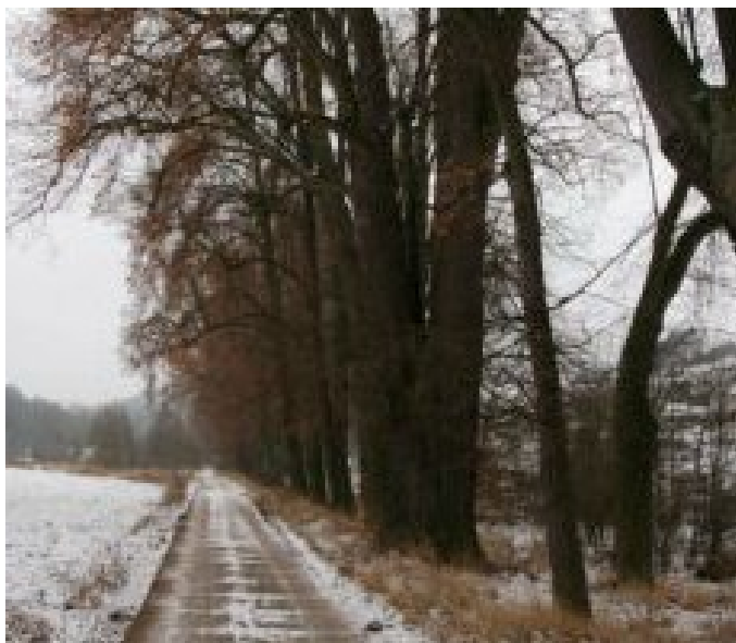
45_2323_Alej Vzdechů_Ostatní - Obslužná komunikace z prefabrikovaných panelů
