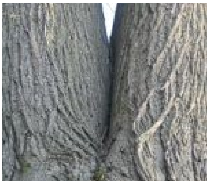
031_2364_Alej Kilometrovka_Kmen - Místo primárního rozvětvení - Tlakové větvení - Detail
