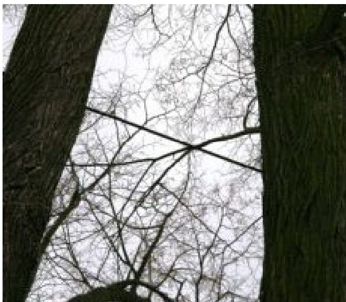
35_2360_Vrčeňská lípa_Koruna - Spodní část - Rigidní bezpečnostní vazba vrtaná - Kovová tyč
