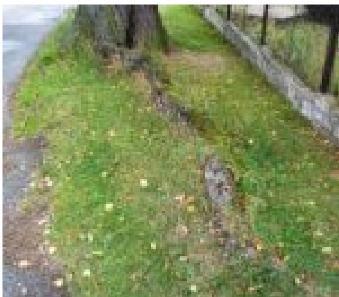
06_2338_Lípa u Boučků_Kořenový náběh - Východní strana - Celkový pohled
