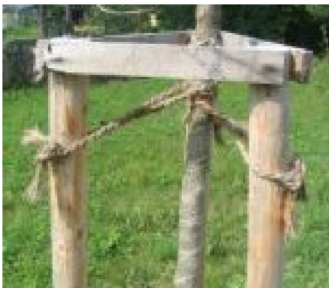
085_2364_Alej Kilometrovka_Strom - Nová výsadba - 2008 - Kotvení dřeviny - Horní část - Detail
