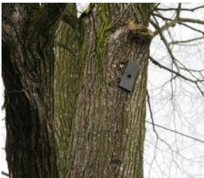
37_2360_Vrčeňská lípa_Koruna - Spodní část - Rigidní bezpečnostní vazba vrtaná - Podložka II
