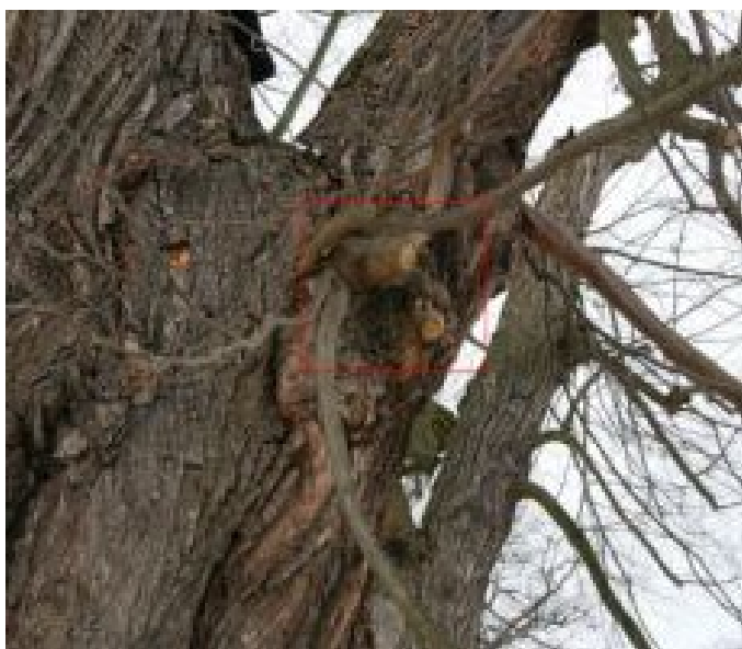
07_5198_Lípa ve Štenovicích_Kmen - Jihovýchodní strana - Redukce výmladků řezem
