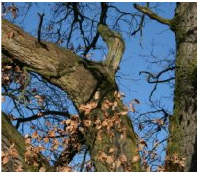
20_2320_Vlastin dub_Úněšov_Sekundární severozápadní samostatná osa - Uschlá větev nad podélnou pr
