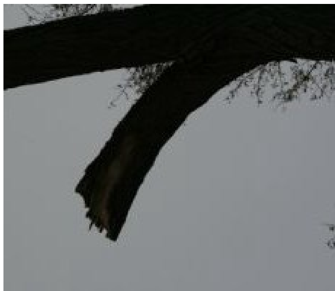
24_2323_Alej Vzdechů_Koruna - Defekt po zlomené větvi - Detail
