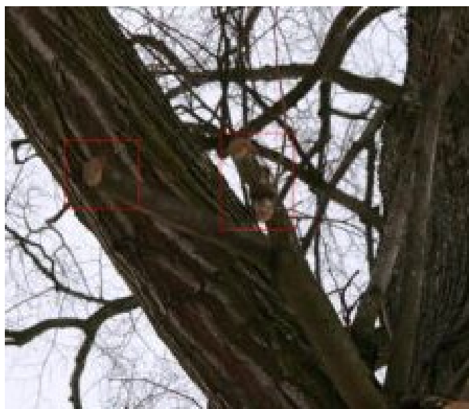
30_2347_Chloumecká lípa_Řezné rány - Sekundární výhony - Jižní strana kmene - Neodborně provedený
