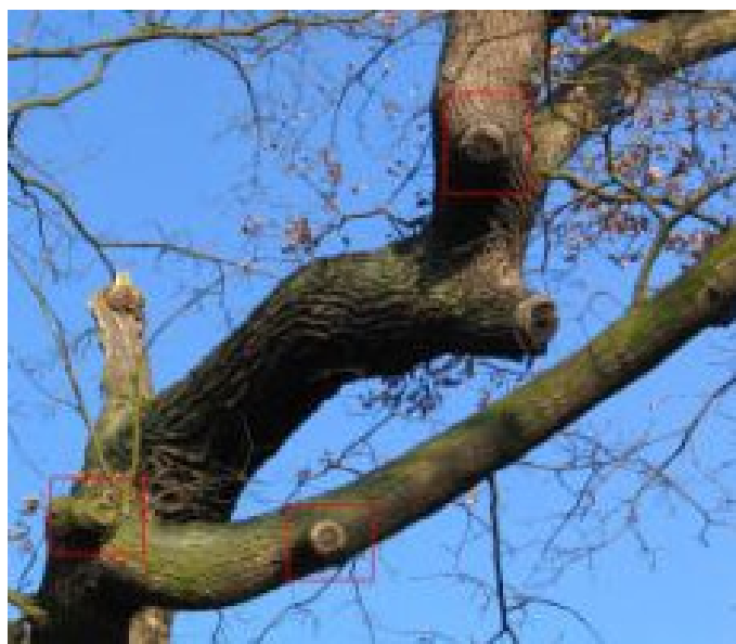
40_2363_Körnerův dub_Řezné rány - Kosterní větve jihovýchodní samostatné osy - Průměr do 0,10 m -
