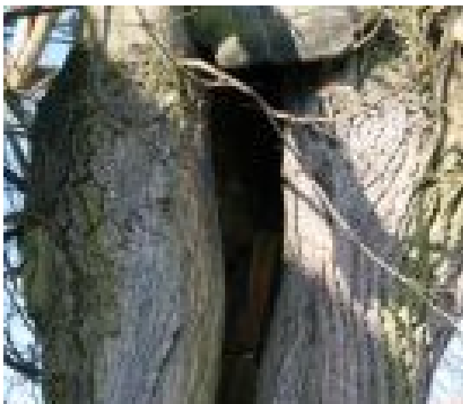
16_2324_2.2_Lípy v Číhané_Kmen - Jihovýchodní strana - Otevřená dutina - Horní část - Zastřešení
