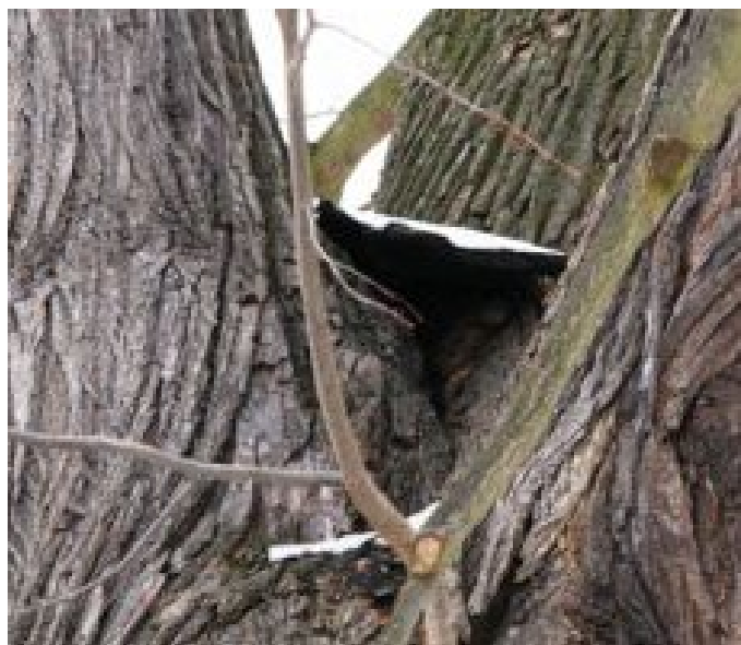
12_5198_Lípa ve Štěnovicích_Kmen - Místo primárního rozvětvení - Jihovýchodní strana - Zastřešení
