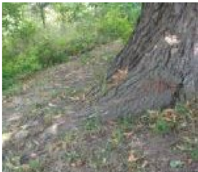
07_2362_2.2_Lípy u Mže_Kořenový náběh - Severozápadní strana
