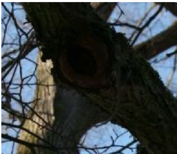
56_2321_Lípa u kaple v Úterý_Řezná rána - Koruna - Severní strana - Spodní část - Průměr do 0,10
