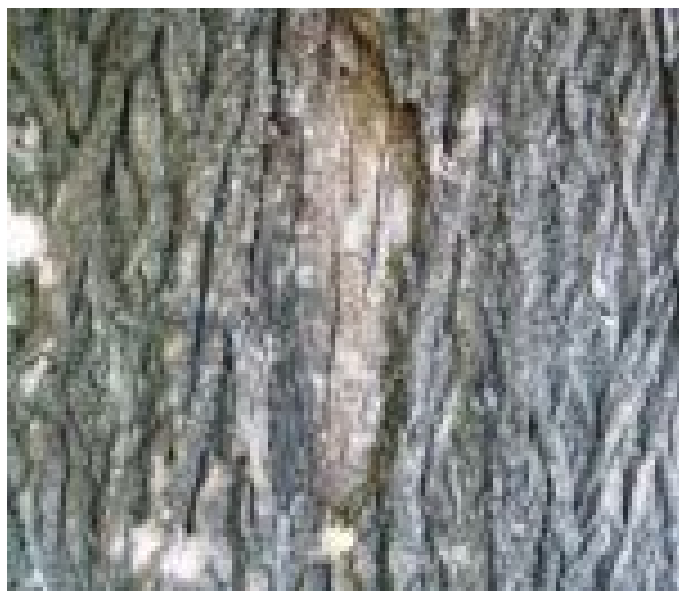
09_2322_Lípa v Dýšíně_Kmen - Jihovýchodní strana - Lokálně odloupnutá borka
