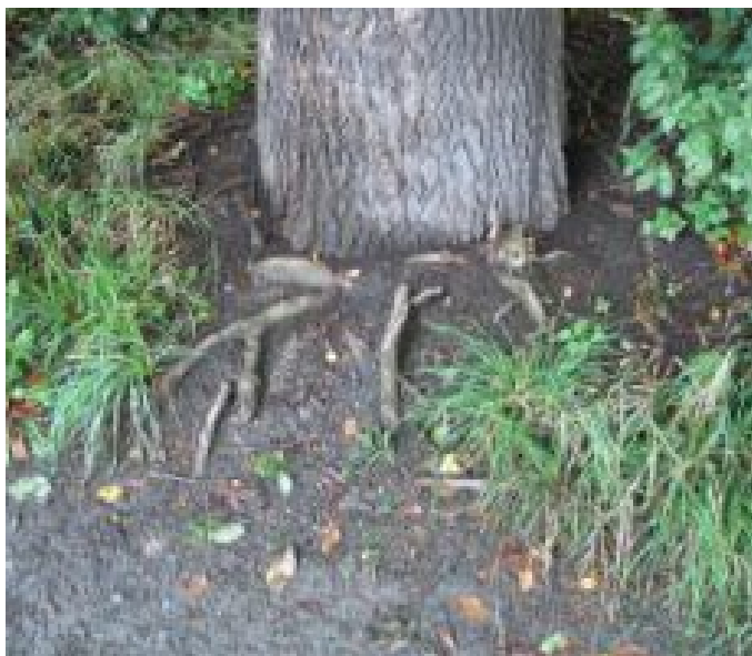
008_2364_Alej Kilometrovka_Kořenové náběhy - Mechanická poškození
