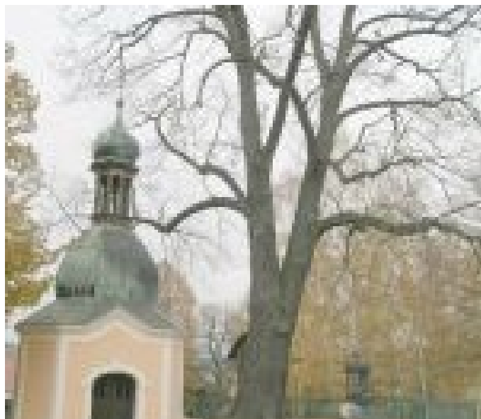
03_4595_Lípa v Břízku_Historie_Kmen - Místo rozvětvení - Východní strana_8.11. 2005_Radka
