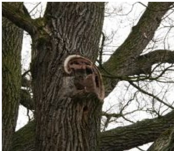
20_2361_Zhůřský křemelák_Řezná rána - Sekundární samostatná osa - Průměr nad 0,10 m
