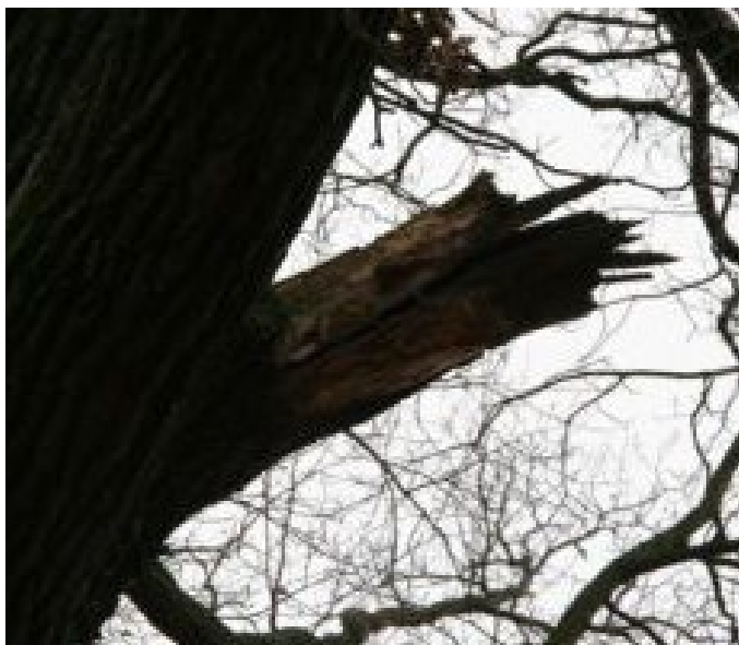
11_Dub nad Zhůří_Koruna - Spodní část - Ušchlá vyvětvená větev - Redukce zlomem - Detail
