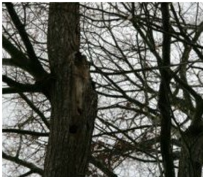
34_2360_Vrčeňská lípa_Koruna - Spodní část - Rána po vylomené větvi
