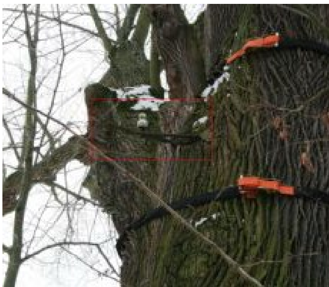
16_2357_Mlynářova lípa_Kmen - Severovýchodní strana - Horní část - Konzola po energetickém rozvod
