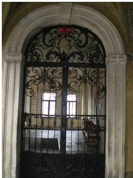
Obrázek 16: Vstup do schodišťového vestibulu
