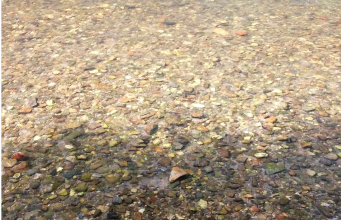
Obr. 3.5 Detail dnové dlažby v toku Opava (2016)
