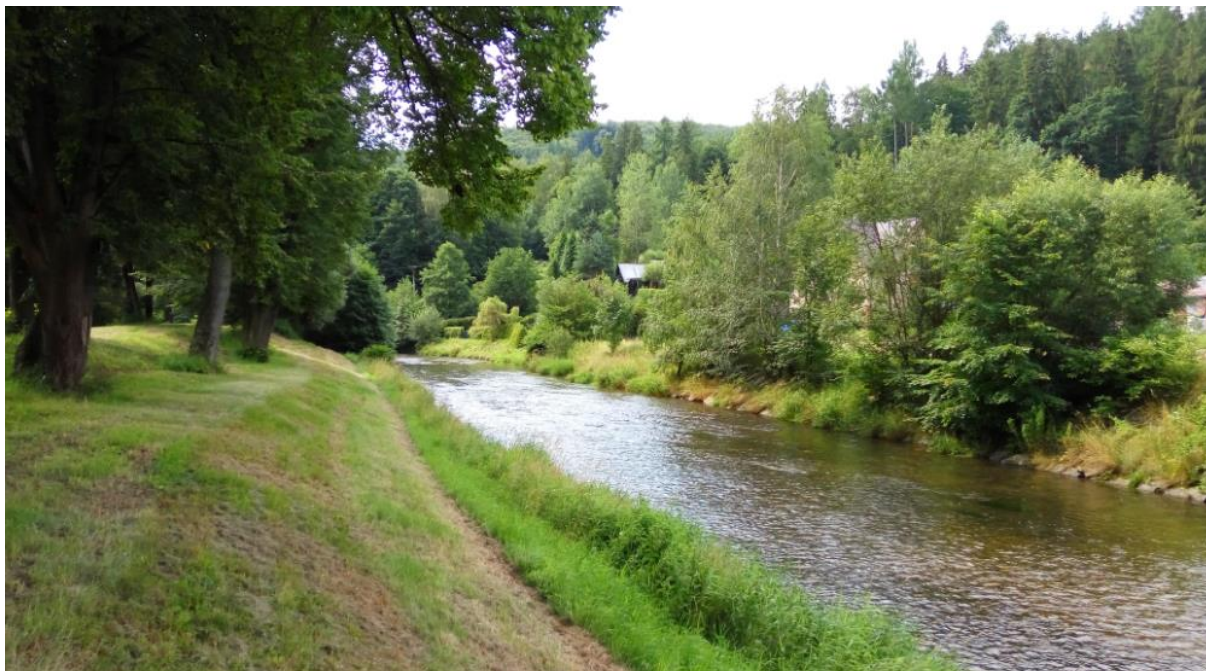
Obr. 6.3 Pohled na řeku Opavu po proudu – v modelu cca km 4,196
