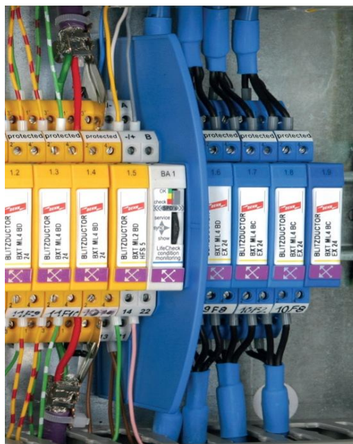
Obr. 9-7: Svodič přepětí BLITZDUCTOR XT EX s modulem BXT ML 4 BD EX; převzato z [29]
