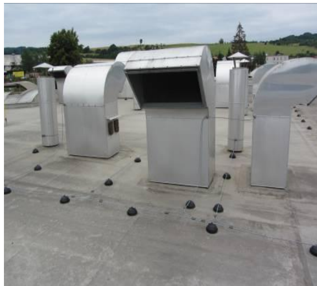
Obr. 8-8: Ukázka podobné situace se střešní vzduchotechnikou
