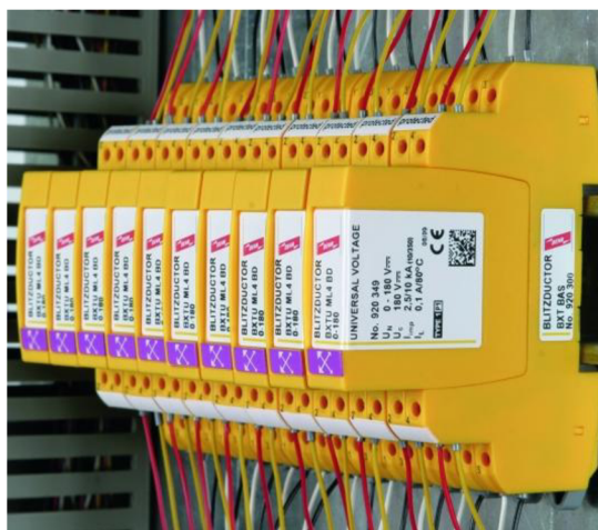
Obr. 9-5: Svodič přepětí BLITZDUCTOR XTU s modulem BXT ML 4 BD 180; převzato z [28]
