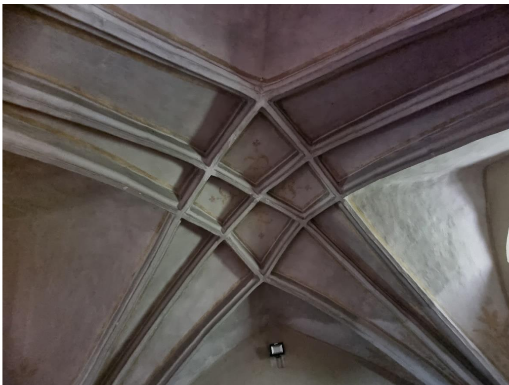
Obr. 27 Zaklenutí kruchty [Markéta Machová, 2023]
