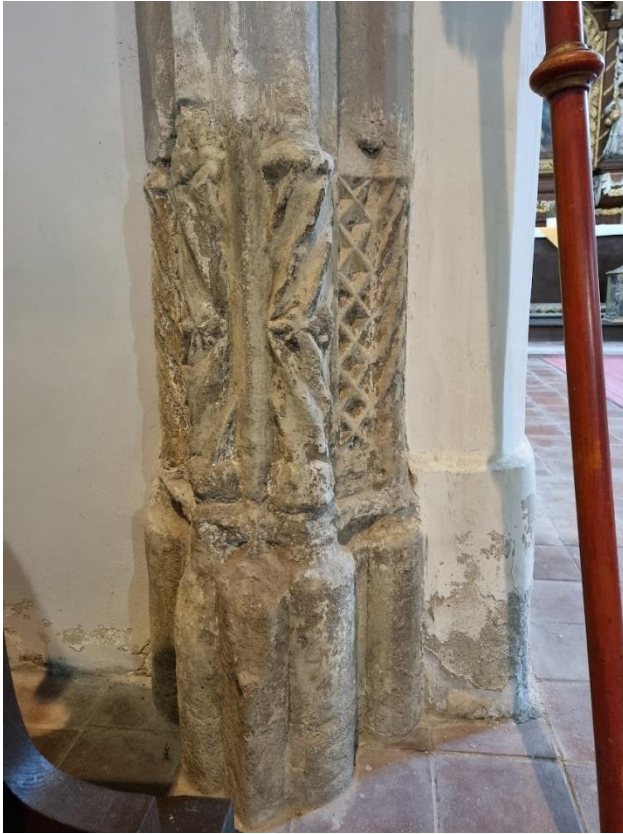
Obr. 97 Detail šroubovitě zatočených trnoží přípor v lodi [Markéta Machová, 2023]
