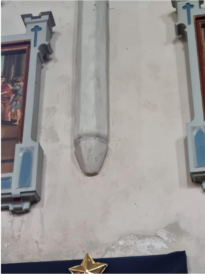
Obr. 24 Detail konzoly a přípory v lodi [Markéta Machová, 2023]
