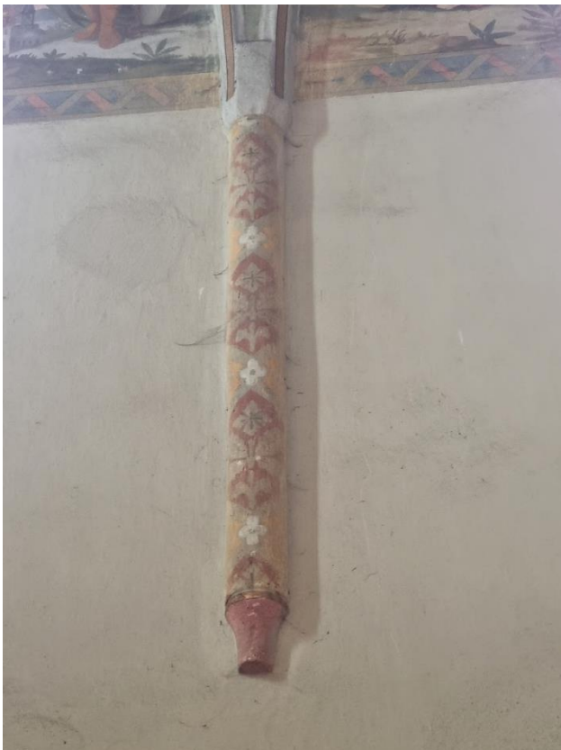
Obr. 20 Detail přípory a konzoly v presbytáři [Markéta Machová, 2023]
