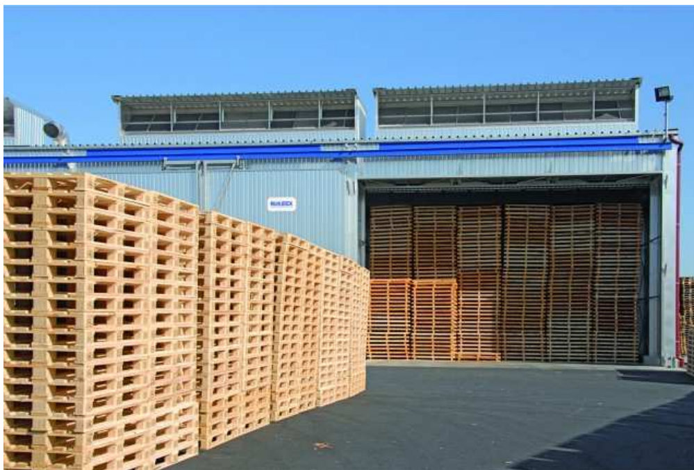
Obrázek č. 4 - Plně funkční technické zařízení (SRS, 2013)
