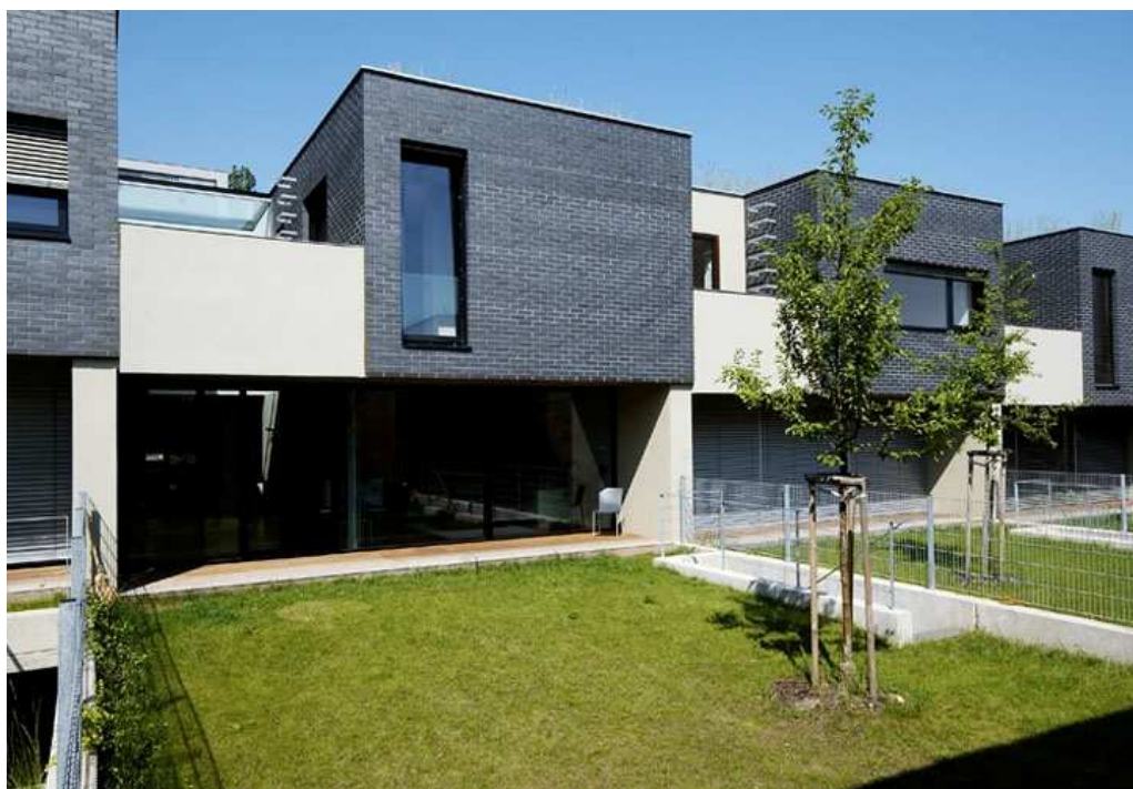
Obr. 25 Obytný soubor Na Krutci vznikl v roce 2007
