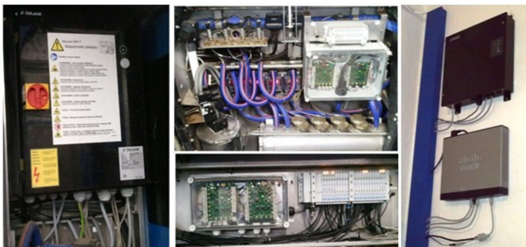
Obr. 22 Instalace součástí řízení DeLaval AMR: Centrální jednotka, PLC a síťové LAN prvky pro spojení s PC
