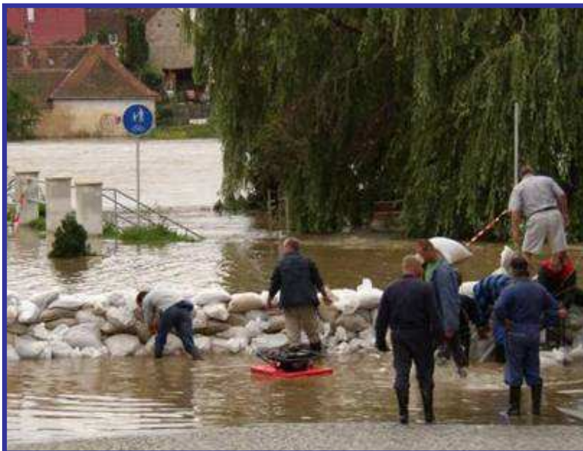
Obrázek 23: Stavba protipovodňové hráze – kladení pytlů s pískem (Mostecká ulice v Týně nad Vltavou) při povodních v roce 2002
