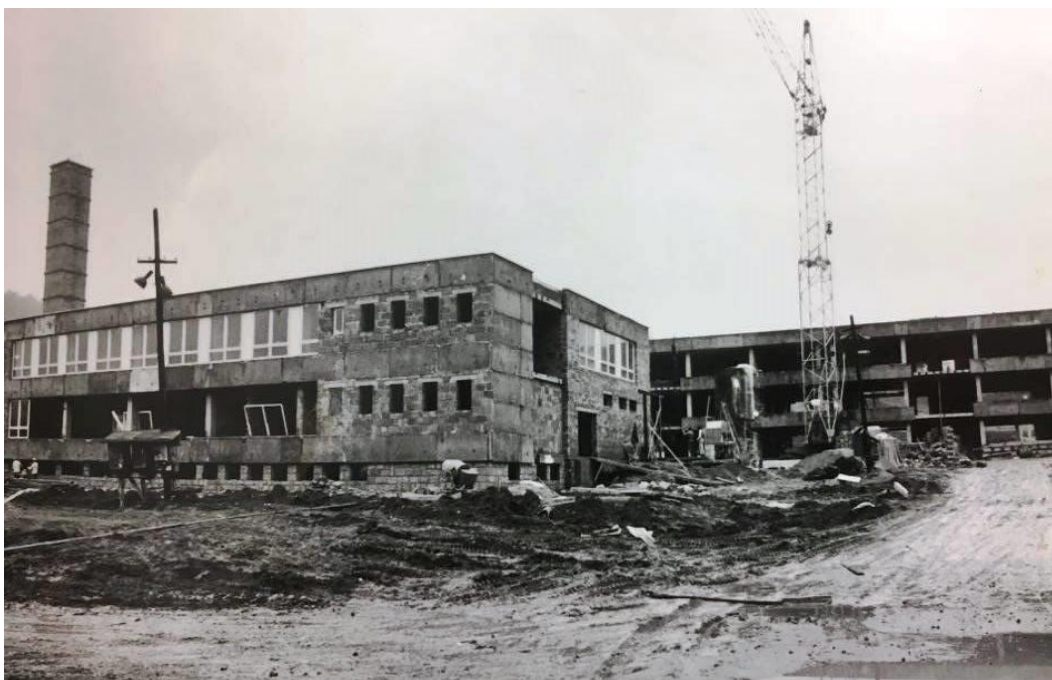
Foto 5 – Stavba nové školy v roce 1973
