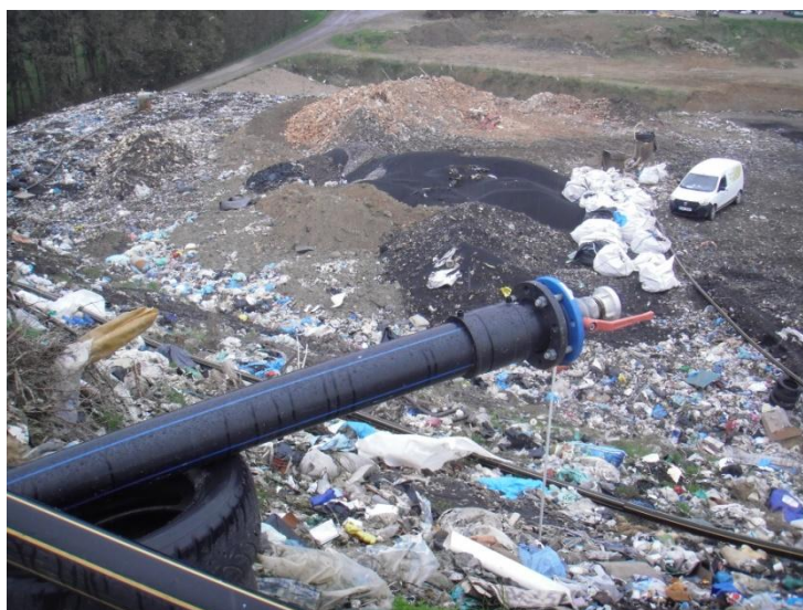
Obrázek 8: Vývod zpětného recyklu skládkové vody
