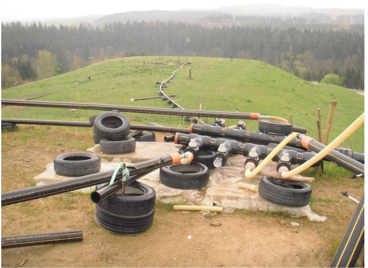
Příloha č. 4: Pohled na rekultivovanou část skládky
