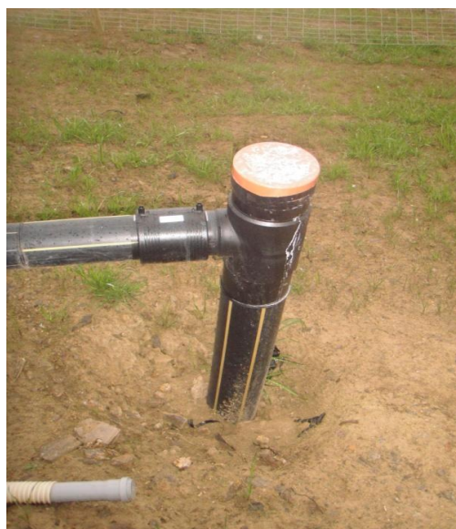
Obrázek 5: Nadzemní část plynosběrného potrubí
