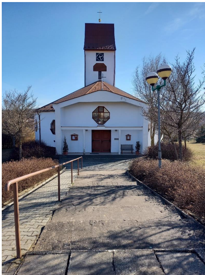
Příloha 11: Vchod do kostela r. 2022
