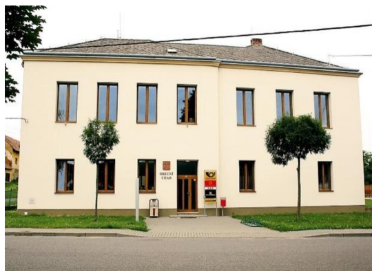
budova školy 2022 – obecní úřad (zdroj: www.obeczadovice.cz )
