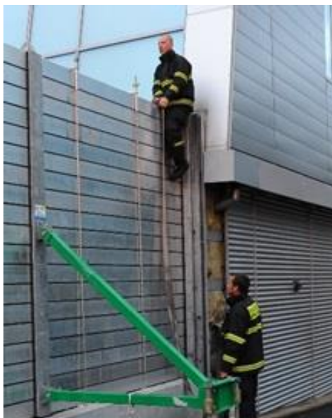
Obrázek 6: Boční vedení na stávajícím objektu
