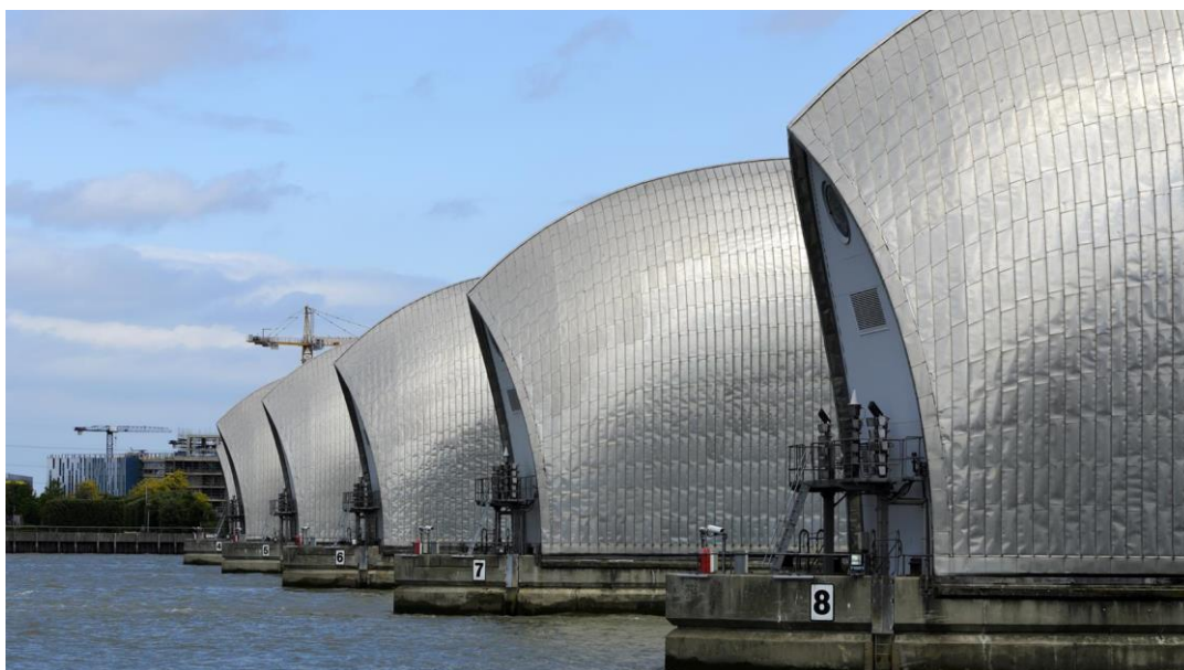
Protipovodňová bariéra v Londýně
