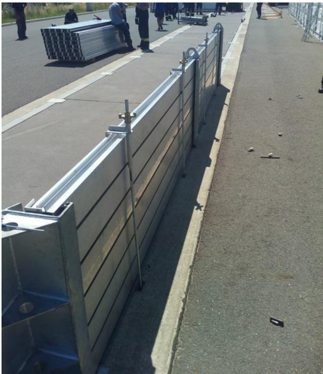
Obrázek 19: Kompletně sestavené mobilní protipovodňové hrazení
