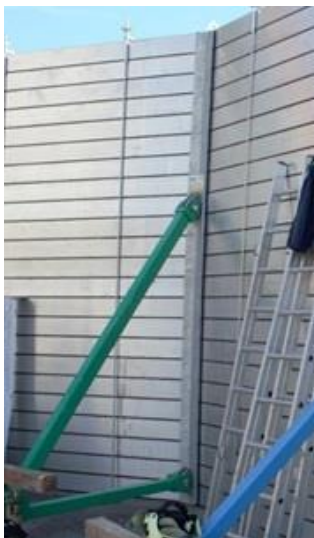
Obrázek 11: Slupice s úhlovým půdorysným lomem v linii hrazení
