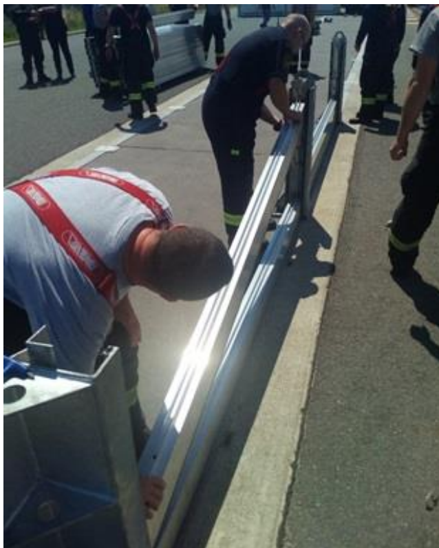
Obrázek 13: Ukládání hradidel mezi slupice
