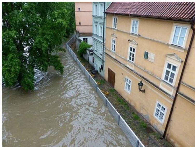
Obrázek 23: Mobilní hrazení v úseku Kampa při povodni v roce 2013
