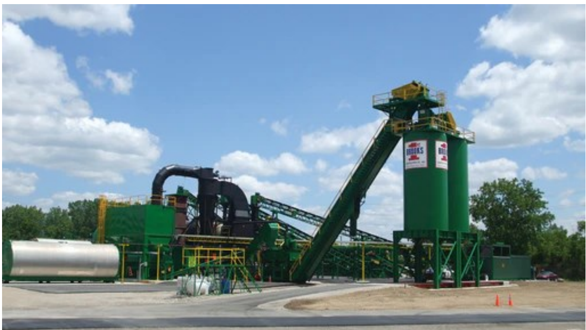
Obrázek 12: Kontinuální obalovna s technologií HyRAP [25]
