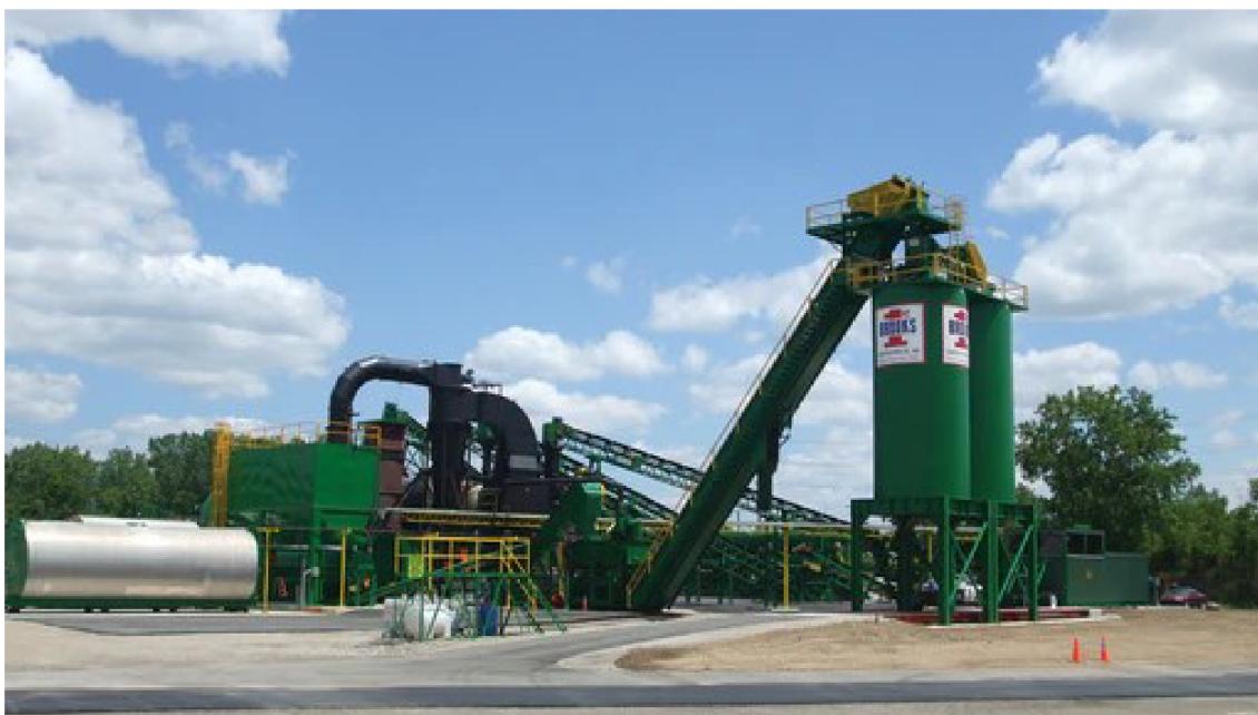
Obrázek 12: Kontinuální obalovna s technologií HyRAP [25]
