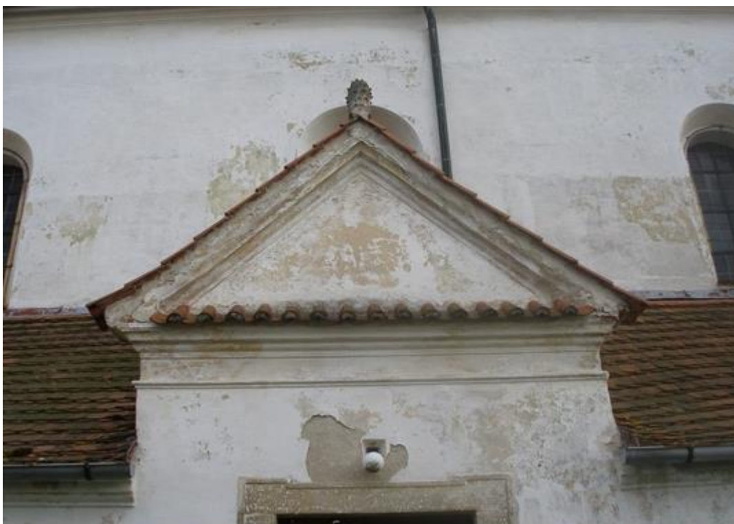
Obr. č. 8 – Kostel sv. Jiří v Blansku u Kaplice, štít nad vstupním portálem, foto: autorka.
