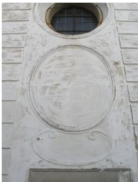
Obr. č. 12 – Kostel sv. Jiří v Blansku, detail západního průčelí, foto: autorka.
