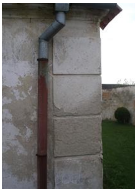
Obr. č. 10 – Kostel sv. Jiří v Blansku, detail bosáže, západního průčelí, foto: autorka.
