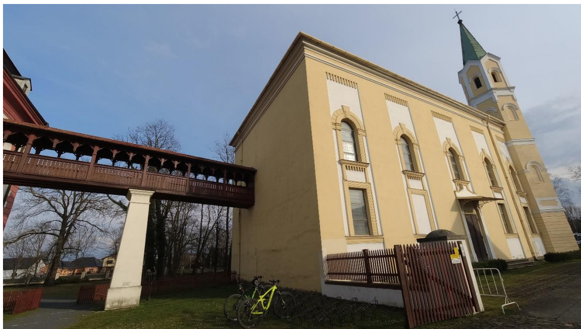
11. Pohled na boční stěnu kostela ze severu a zadní stěna kostela s dřevěným mostem
