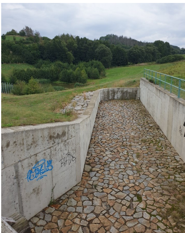
Obrázek 2.15: Vtok do bezpečnostního přelivu (vlastní)
