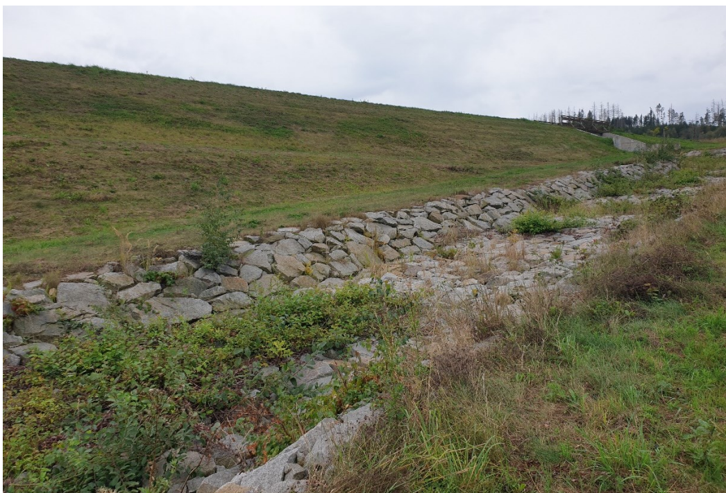
Obrázek 2.14: Bezpečnostní přeliv poldru (vlastní)
