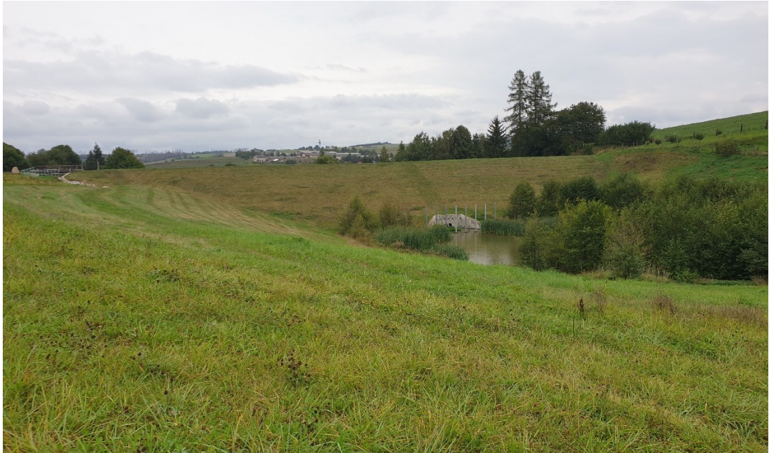
Obrázek 2.12: Protipovodňové opatření poldr (vlastní)
