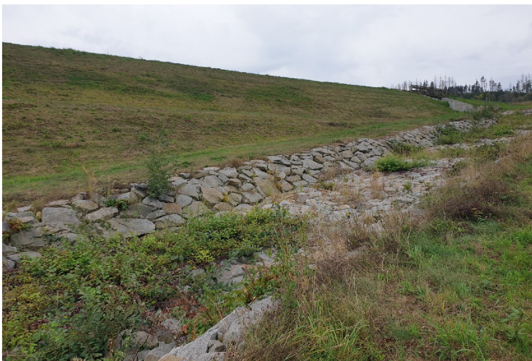
Obrázek 2.14: Bezpečnostní přeliv poldru (vlastní)
