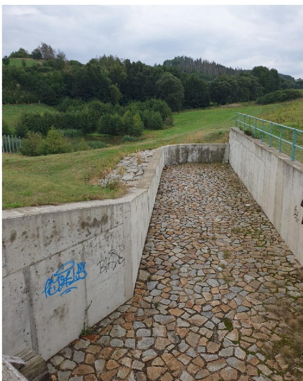
Obrázek 2.15: Vtok do bezpečnostního přelivu (vlastní)
