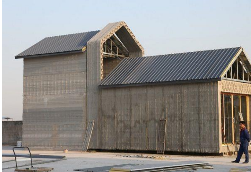
Obr. 1 : Stavba pozostávajúca z častí vytlačených pomocou 3D tlačiarne (zdroj: Designboom , 2014)
