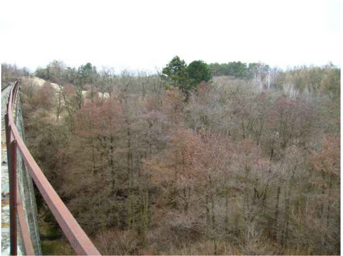
Obr. č. 9. – Zbytek fragmentu původního lesa pod Ratbořským viaduktem.
