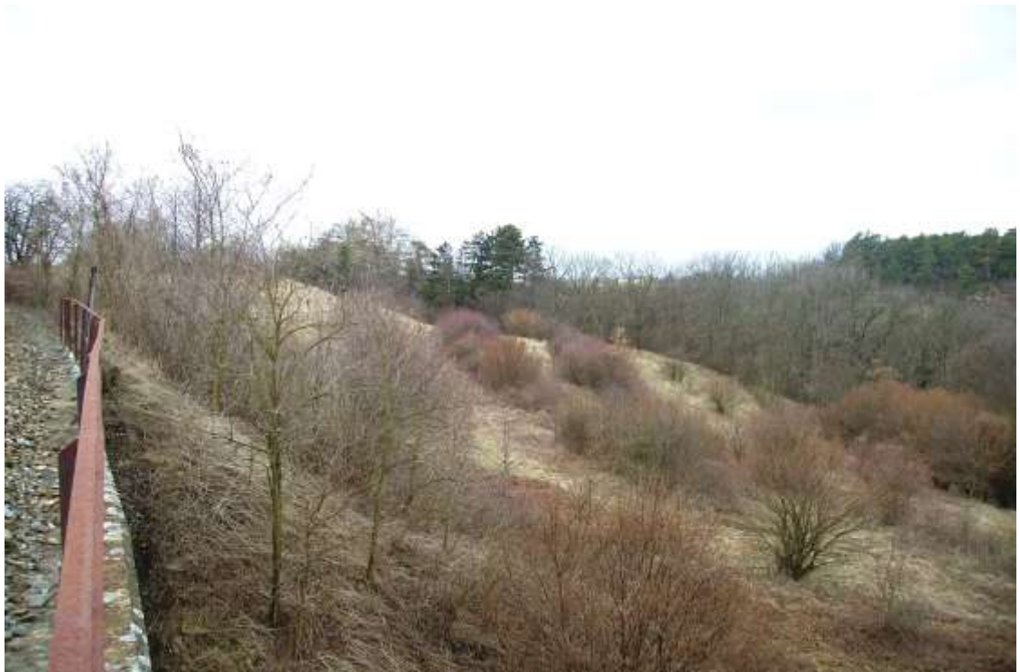
Obr. č. 8. – Zarůstající stráž keři u Ratbořského viaduktu.
