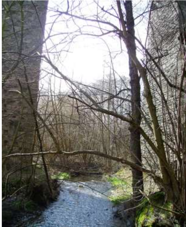
Obr. č. 3. – Údolí potoku Polepky pod Ratbořským viaduktem.
