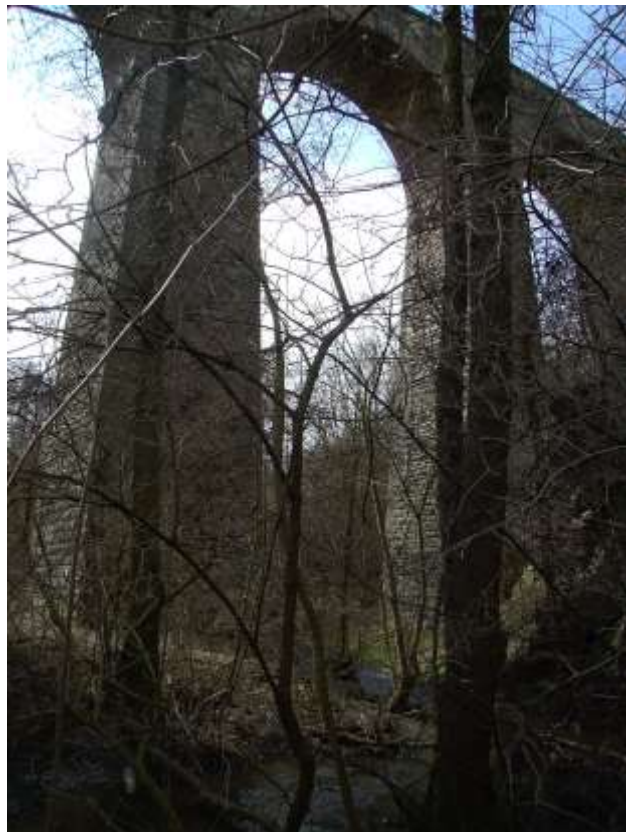
Obr. č. 4. – Údolí potoku Polepky pod Ratbořským viaduktem.
