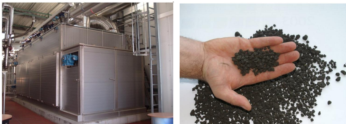
Obr. 2-18 Pásová sušárna HUREB BT a vysušený kal [49]
