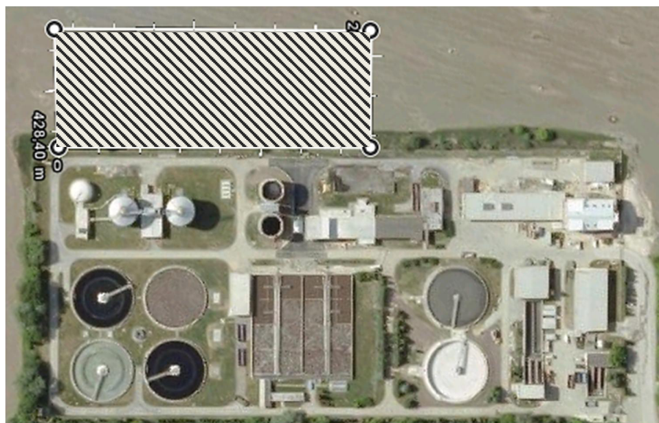
Obr. 4-9 Záběr plochy pro solární sušárnu
