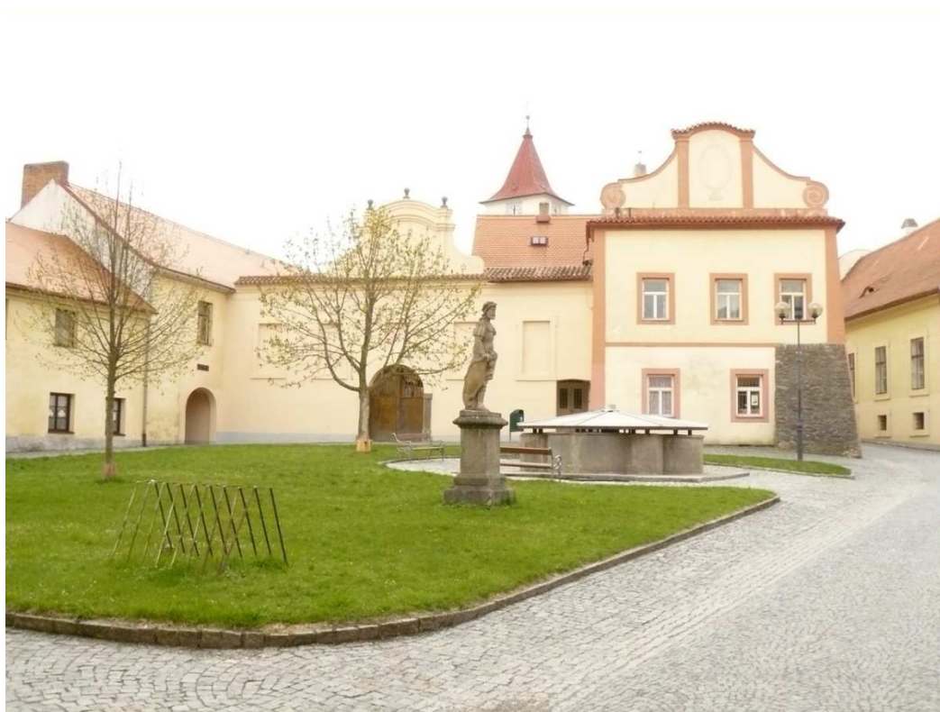
Obrázek 19. ↗ Jihovýchodní křídlo zámku se vstupem
