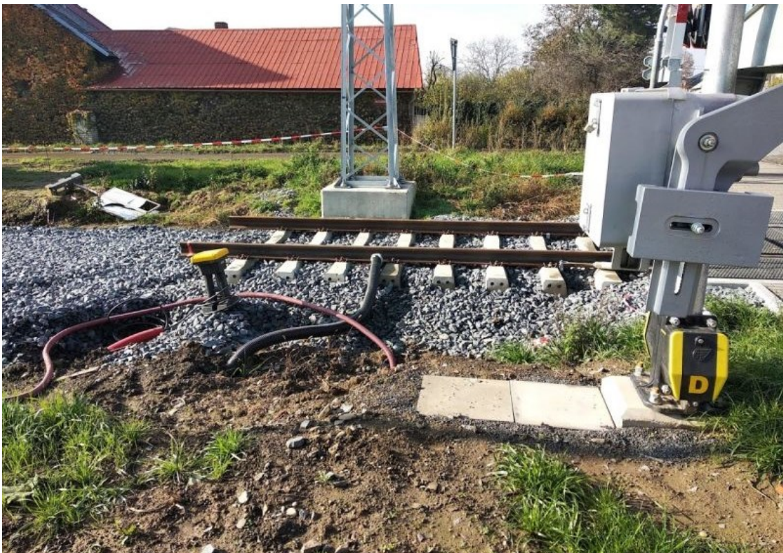
Obr. 2.6 Spoj kolejnice u modernizovaného ŽP
