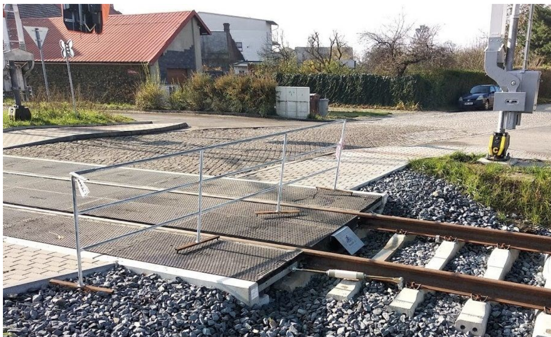
Obr. 2.7 Rozebíratelný povrch přejezdové vozovky ŽP
