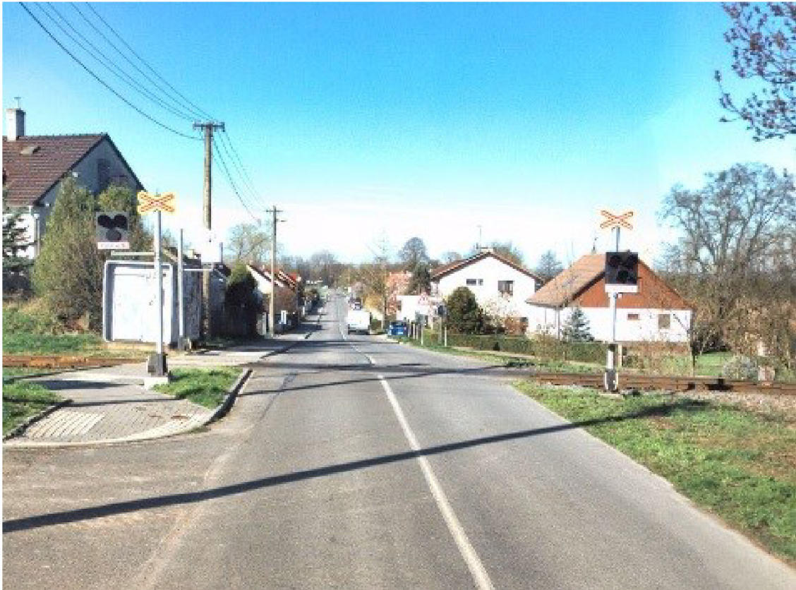
Obr. 4.3 ŽP P4203 ve směru jízdy z obce Bohuňovice (před modernizací)
