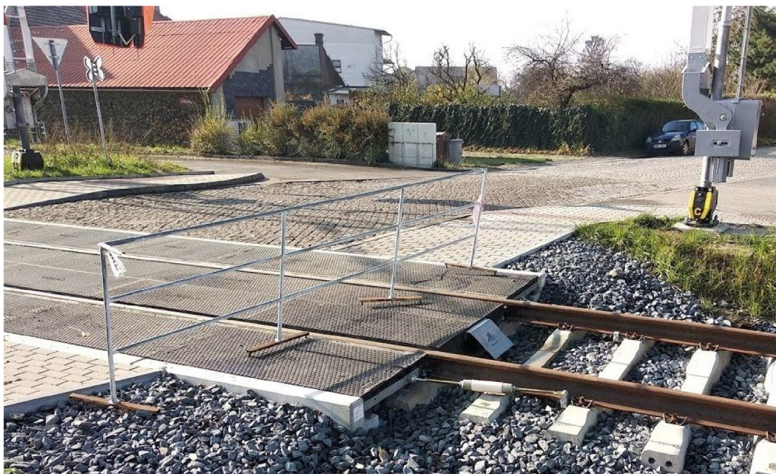
Obr. 2.7 Rozebíratelný povrch přejezdové vozovky ŽP
