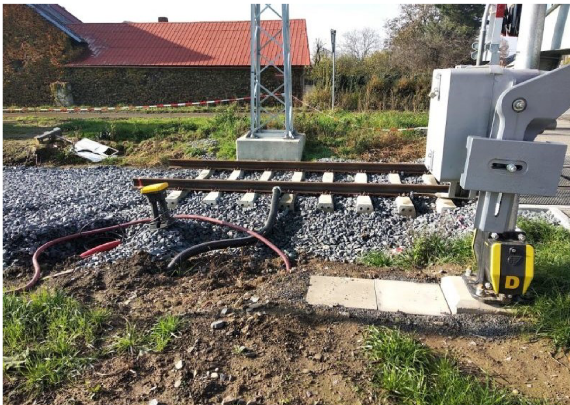
Obr. 2.6 Spoj kolejnice u modernizovaného ŽP
