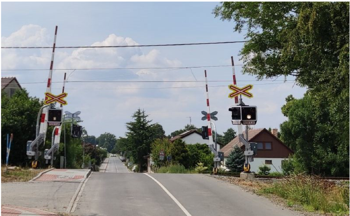
Obr. 4.5 ŽP P4203 ve směru jízdy z obce Bohuňovice (po modernizaci)
