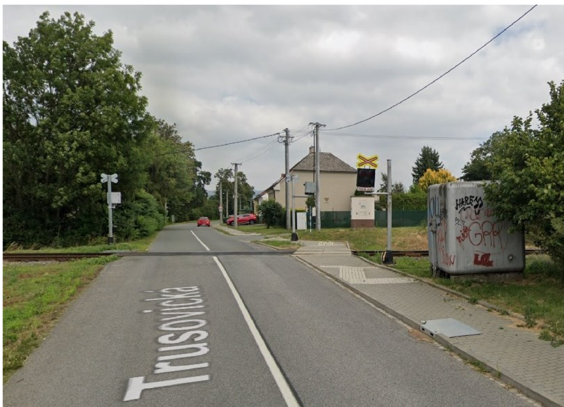
Obr. 4.2 ŽP P4203 ve směru jízdy do obce Bohuňovice (před modernizací)
