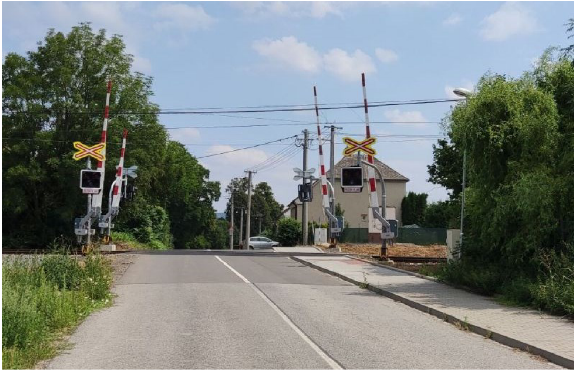
Obr. 4.4 ŽP P4203 ve směru jízdy do obce Bohuňovice (po modernizaci)
