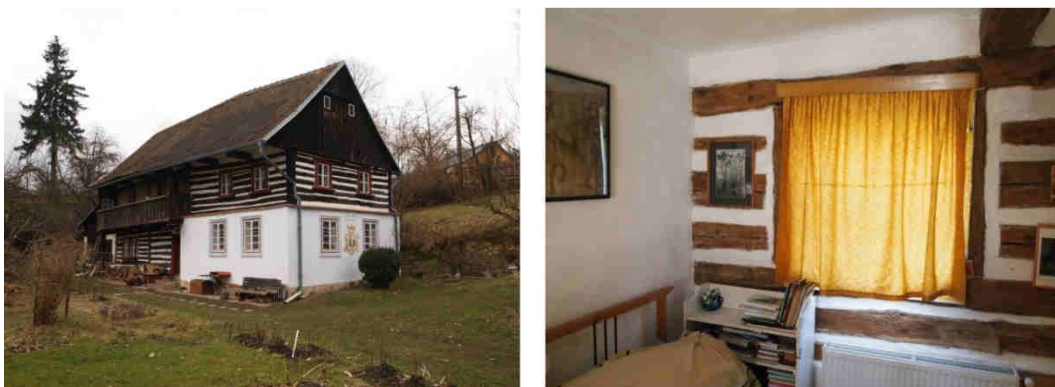
Obrázek 14: Poloroubené historické dvoupodlažní stavení, Záhrádky
