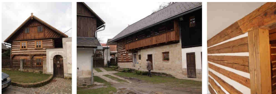
Obrázek 15: Roubené historické dvoupodlažní stavení, Nosálov
