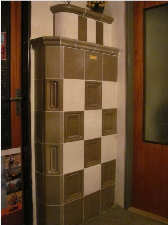
Obrázek C 3 - Hypokaustová teplosměnná plocha v patře RD
