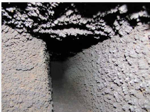
Obrázek C 9 - Šamotový patrový akumulční tahový systém
