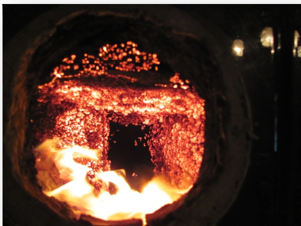
Obrázek C 10 - Vypalování sazí v tahovém systému
