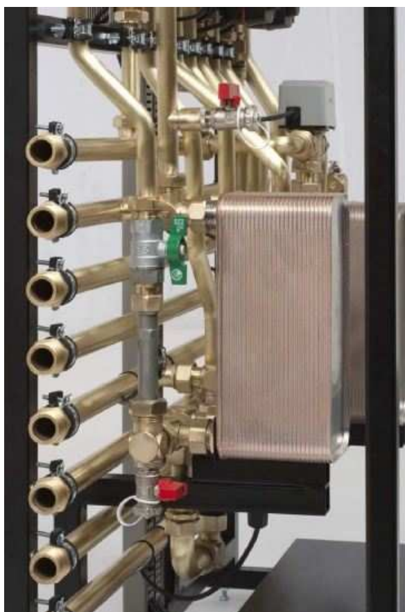
Obrázek B 44 - Deskový výměník pro přípravu TV (7)
