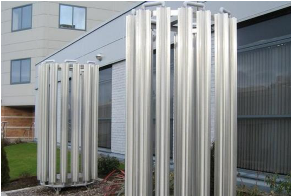
Obrázek 28. Pasivní výparník firmy Octopus Energy [20]
