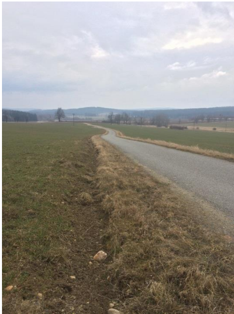
Obrázek 42: Zrealizovaná cesta C1 s oboustranným příkopem
