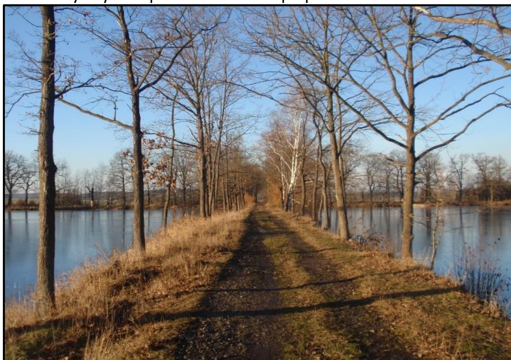
Obr. 5. bývalý násep železniční tratě, foto: autor
