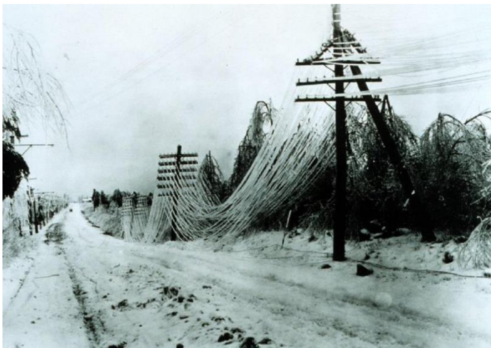
Obr. 8: Velmi silná ledovka dokáže poškodit elektrická vedení (Wikimedia Commons ©2020)
