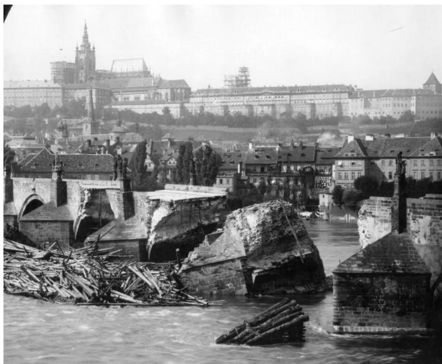
Obr. 17: Rozsah poškození Karlova mostu po povodni v roce 1890 (ČTK ©2020)
